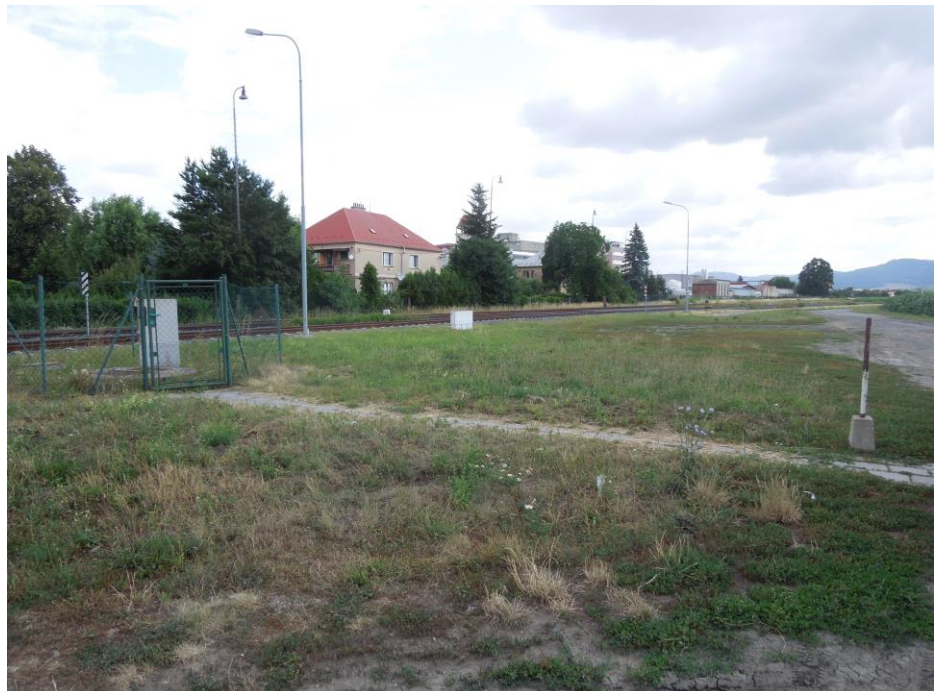
Plochy u železniční vlečky – zde plocha kolem čerpací stanice
