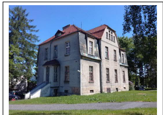
Obr.2 - Budova HTO z jihu
