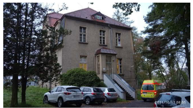
Obr.4 – Budova HTO z východu
