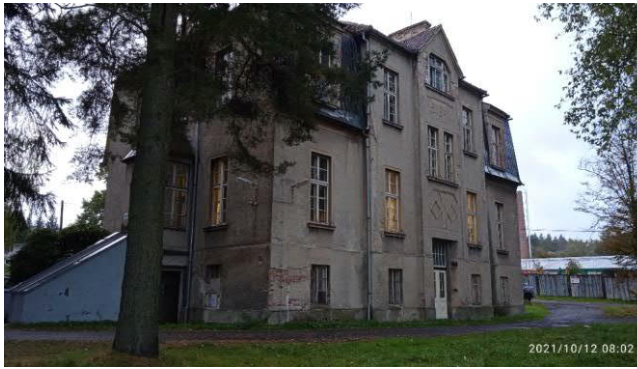
Obr.3 – Budova HTO ze severu
