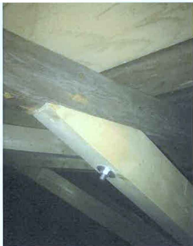
Detail zhlaví nově zhotovených šikmých vzpěr točny.
