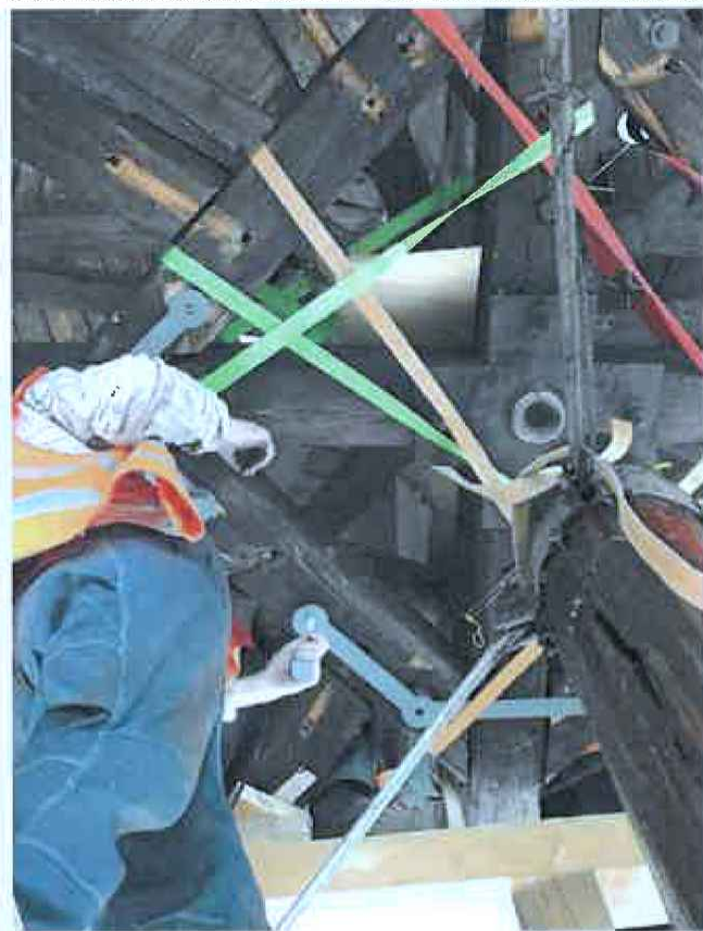
Detail horní části středového sloupu točny před osazením horního ložiska a distančních prvků.
