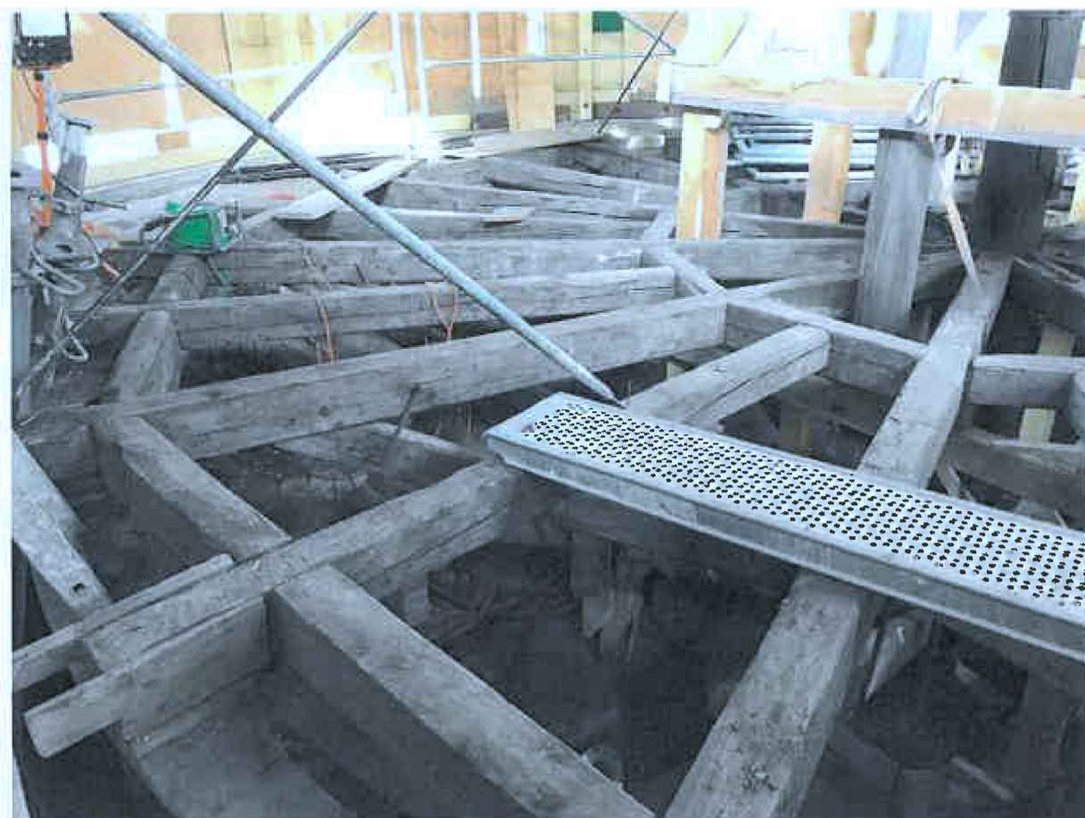
Detail šikmých vzpěr točny před demontáží.
