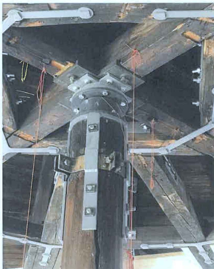
Detail horní části středového sloupu po osazení ložiska a ztužujícího a distančního prvku.
