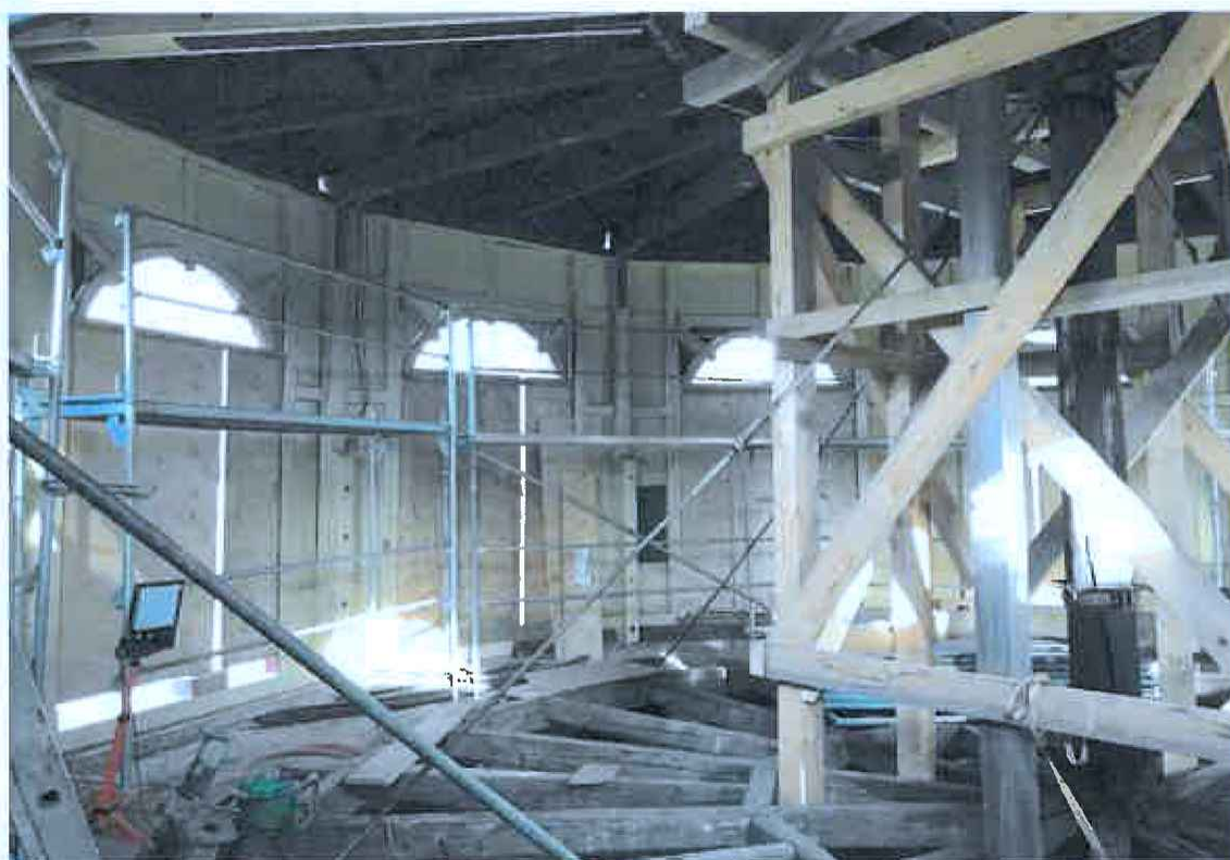
Průběh aplikace nových povrchových úprav na vnitřním plášti objektu.
