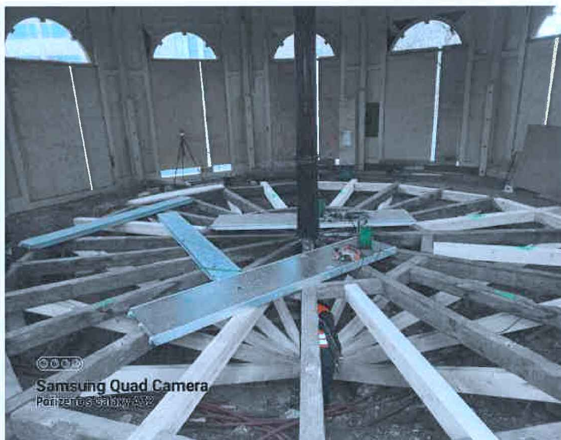
Rozsah výměn nově zhotovených šikmých vzpěr a horizontálních trámů točny.
