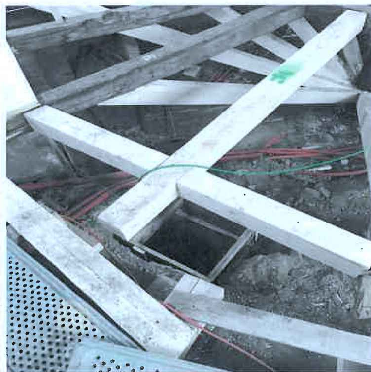
Detail nově zhotovených replik stávajícího krátče a vnější výměny točny.
