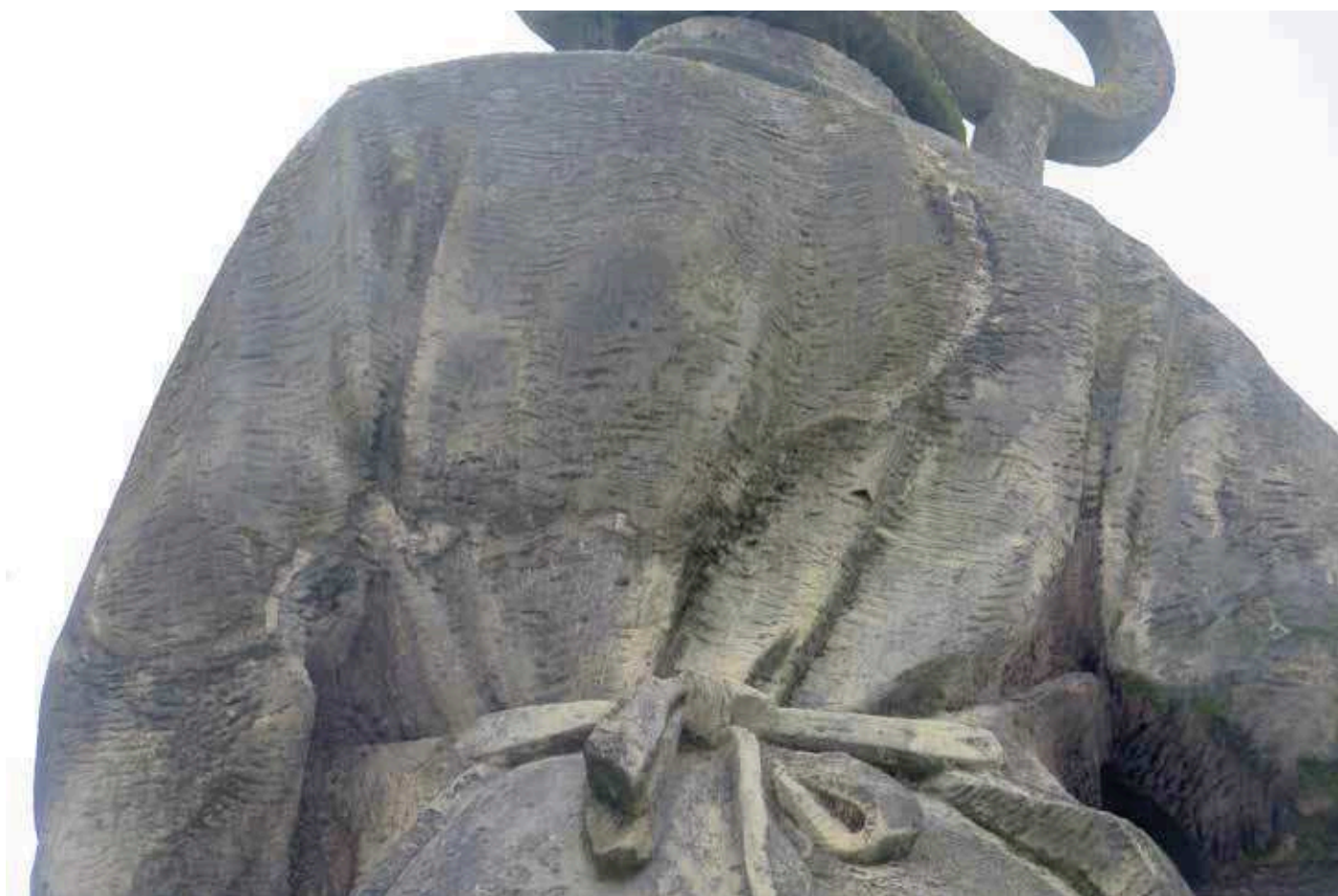
details plastických defektů, kamenné doplňky, patrná degradace spárování
