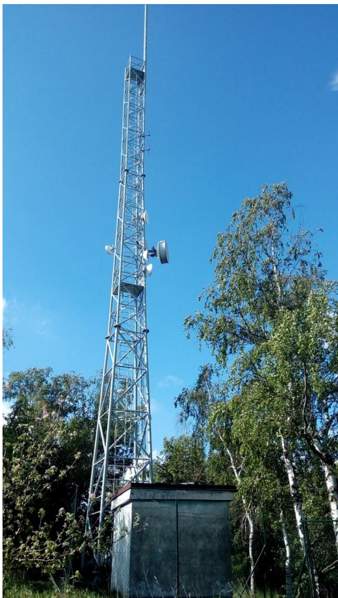
Obr. 1 – Pohled na stanoviště
