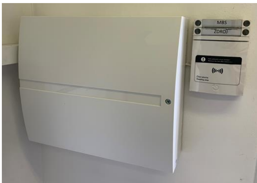
Obr. 7 – JABLOTRON ústředna JA-107K a přístupový modul JA-114E
