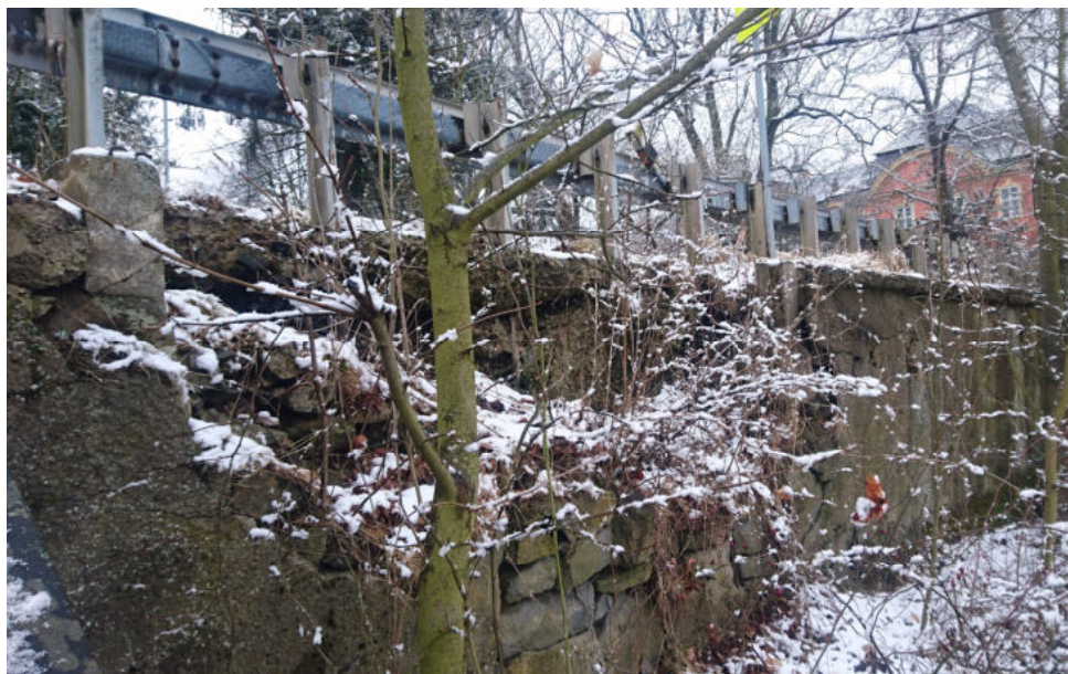
Pravá opěrná zeď na vzdušné straně hráze, visutý chodník se zavěšeným plynovodem, dole uprostřed uzávěr vodovodu, dole vpravo revizní kanalizační šachta
