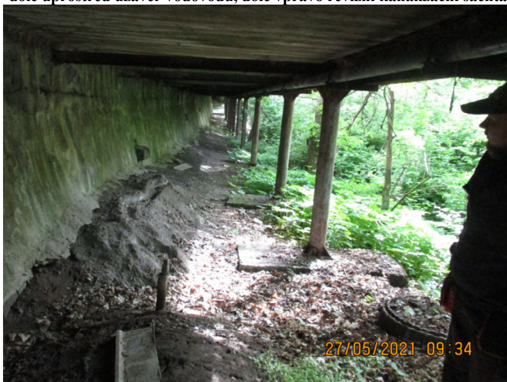
Pravá opěrná zeď na vzdušné straně hráze, visutý chodník se zavěšeným plynovodem, dole uprostřed uzávěr vodovodu, dole vpravo revizní kanalizační šachta
