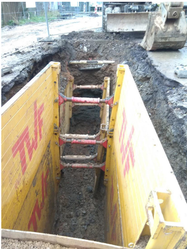
Výkop pro splaškovou kanalizaci, v místech před šachtou ŠAA 38
