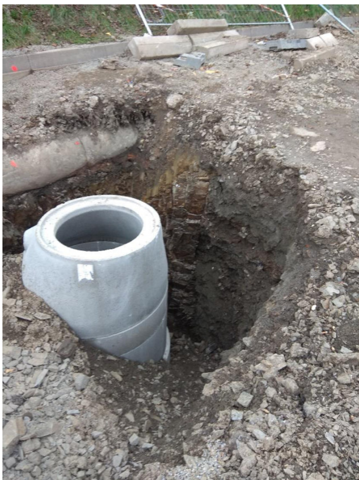
Výkop v místě šachty 1.07
