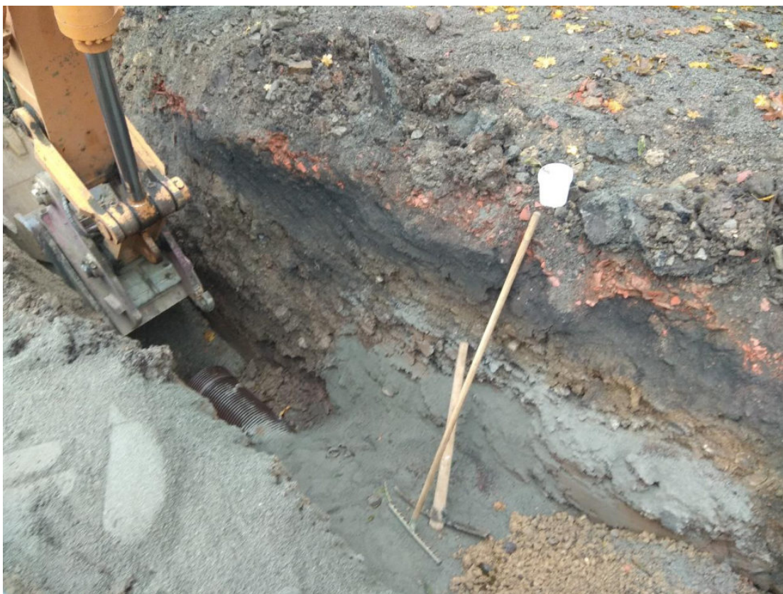
Výkop od šachty 1.14 k šachtě 1.15
