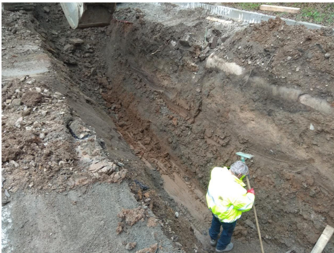
Výkop před šachtou 1.03
