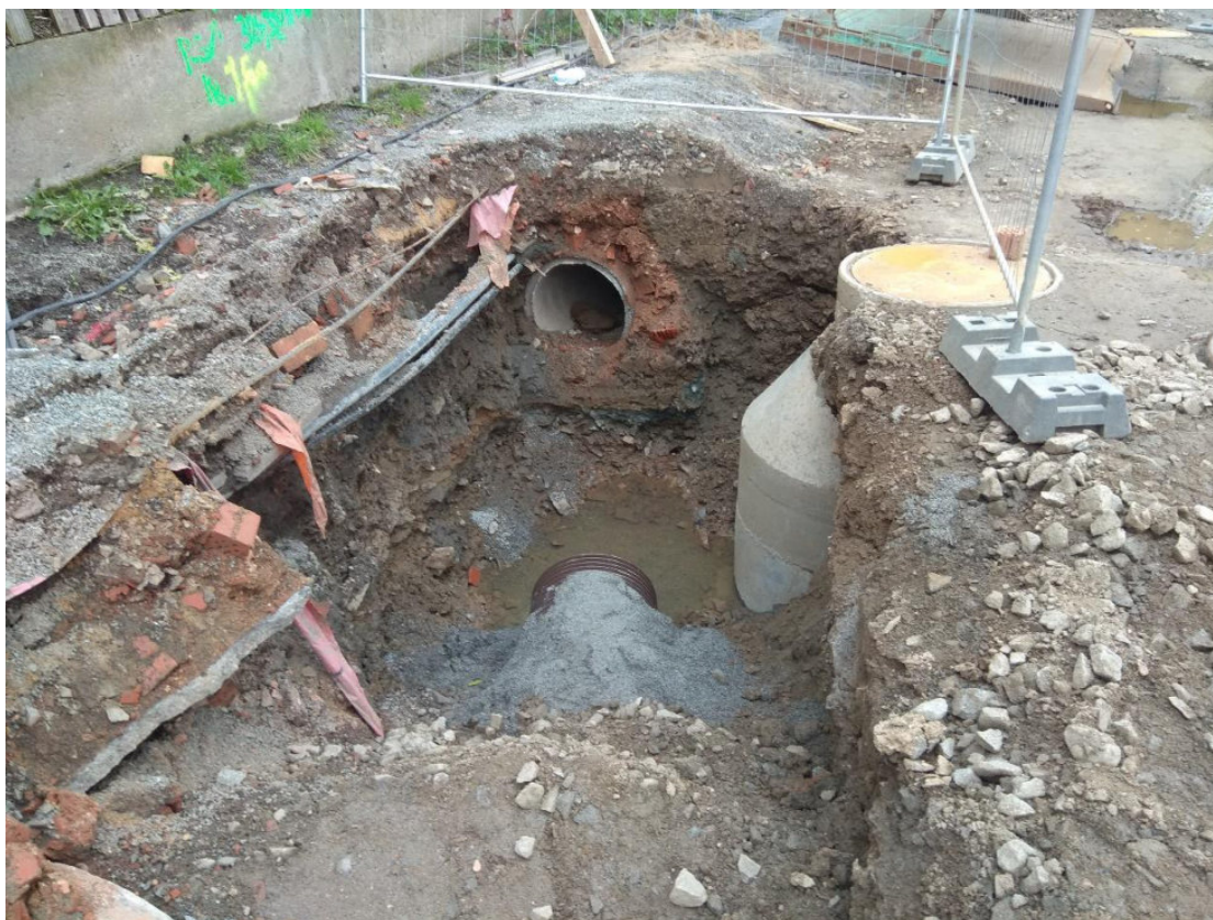
Výkop v místě šachty 1.02
