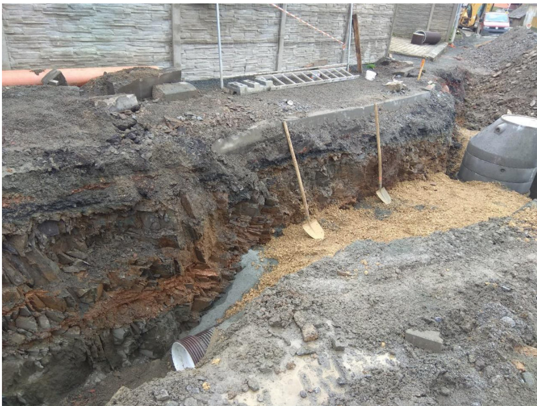
Výkop mezi šachtou 1.09 - 1.10, pohled k šachtě 1.09
