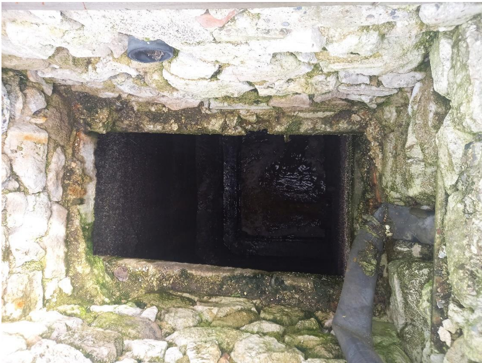
Obr. 8 Pohled do stávající otevřené kanalizační šachty v areálu stávající HČS
