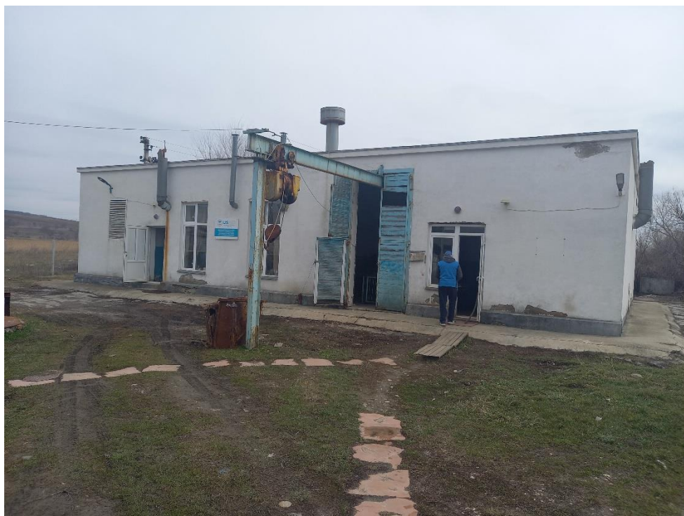
Obr. 9 Pohled na stávající nadzemní část HČS, tedy na zděnou budovu
