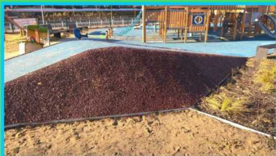
Ukázka realizace na nerovném terénu a svazích....
