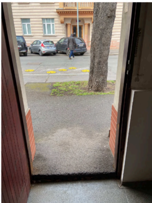
Zárubeň zapuštěná do chodníku
