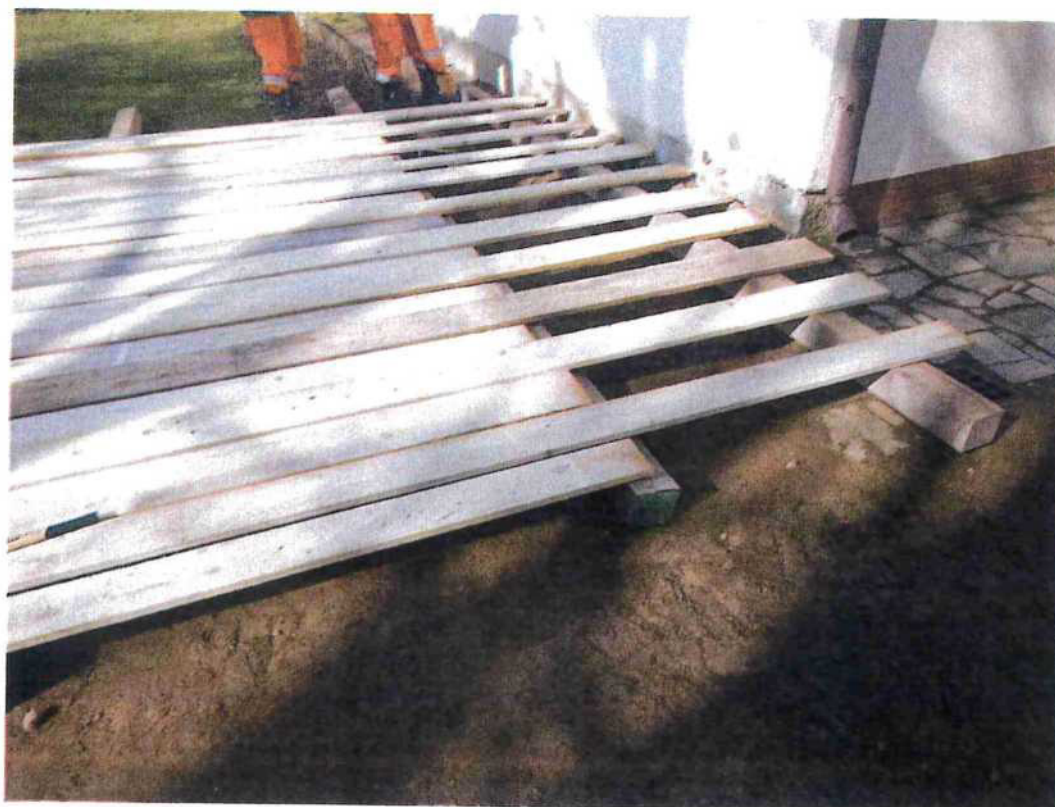
Průběh prací na zajišťování místa propadu
