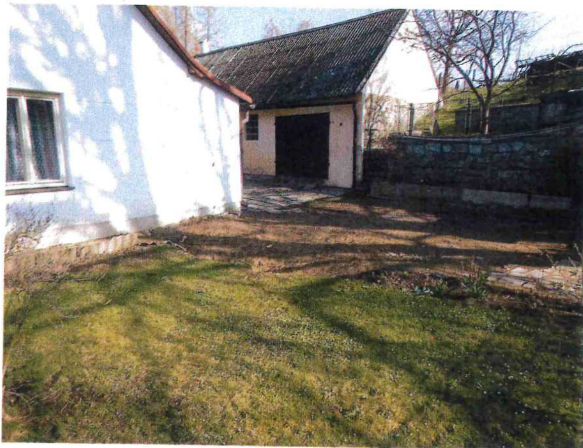
Stav po zasypání majitelem objektu
