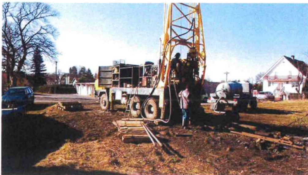
Vrtné práce na sanačních vrtech u propadu Božičany XIII.
