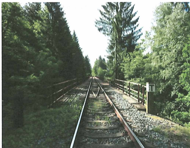
Pohled protisměru staničení
