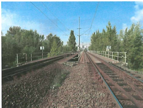
Pohled ve směru staničení
