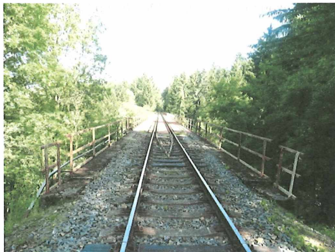
Pohled ve směru staničení
