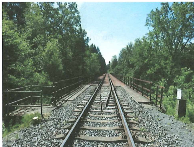
Pohled protisměru staničení
