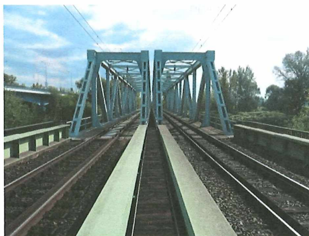
Pohled protisměru staničení
