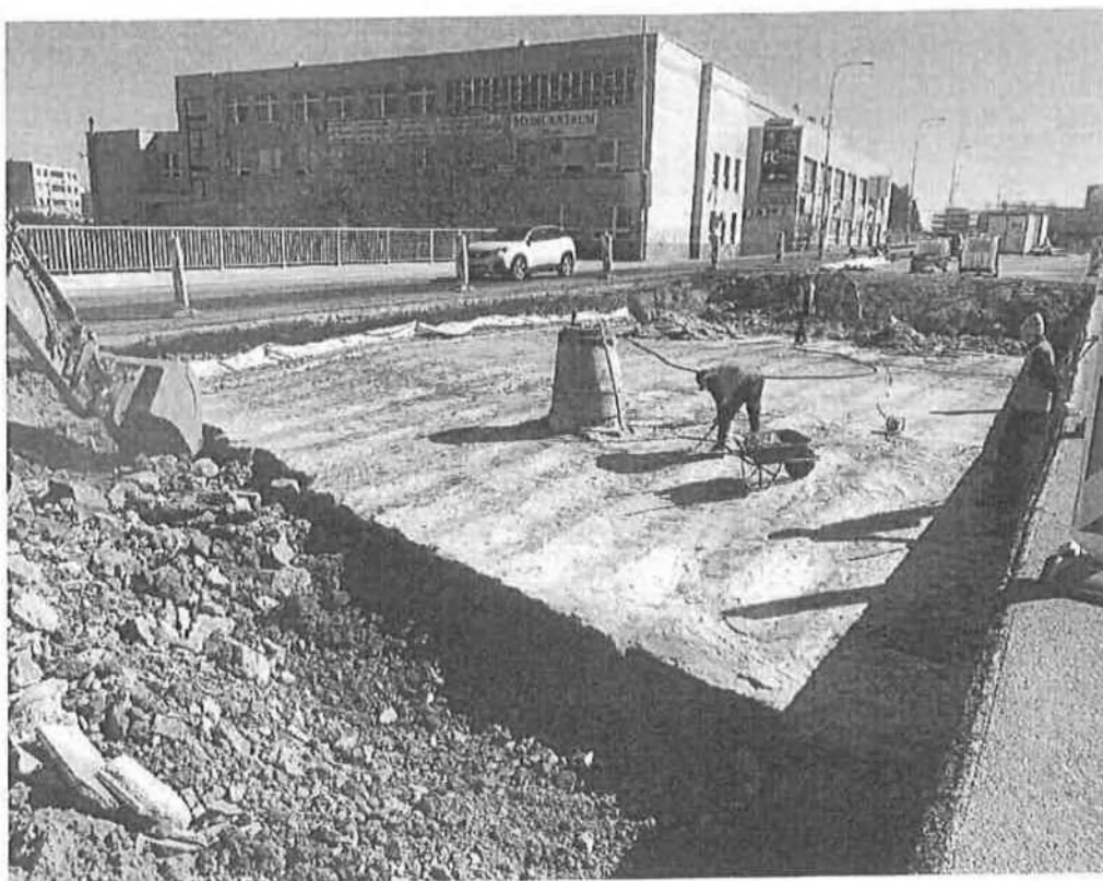
3. Přechodové oblasti - bourání přebetonávek
