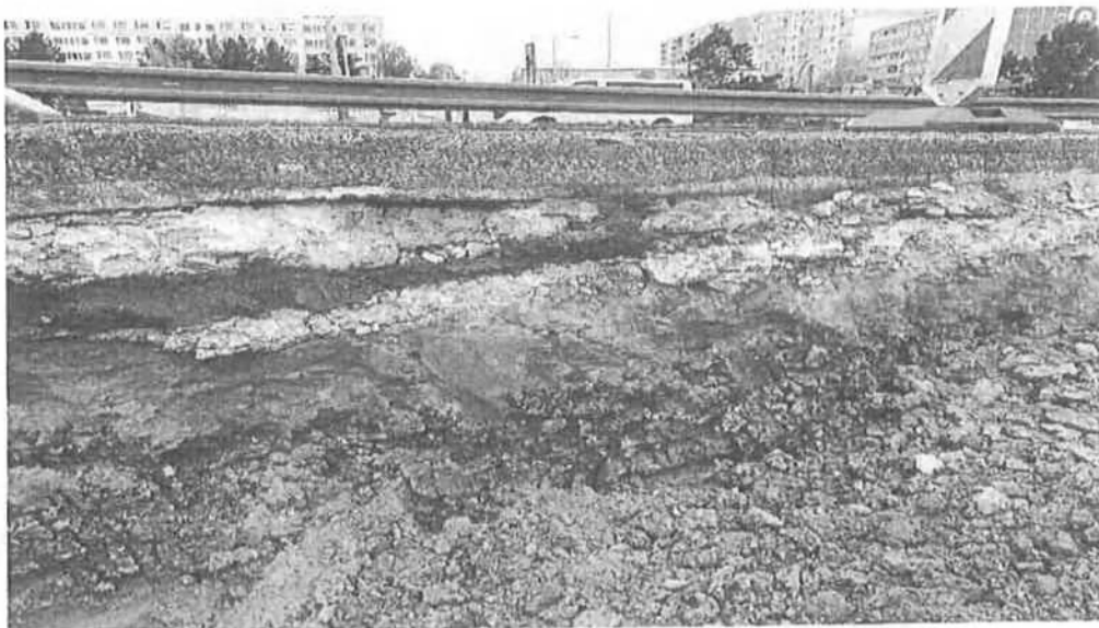
3. Přechodové oblasti - bourání přebetonávek
