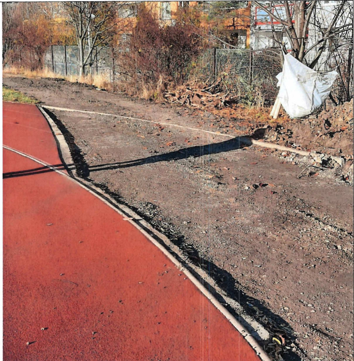
Oprava dráhy nad rámeč SOD
