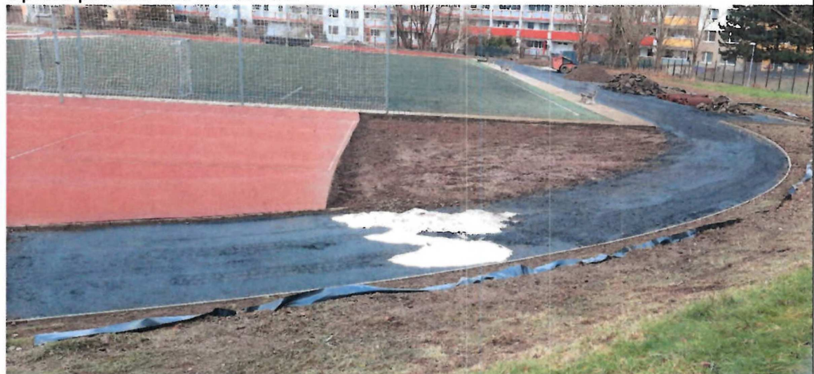
Oprava povrchu nad rámeč SOD
