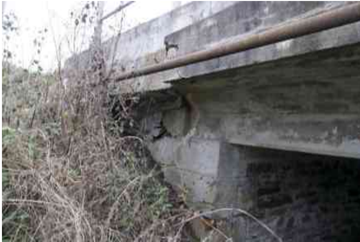
Uložení na opěře
