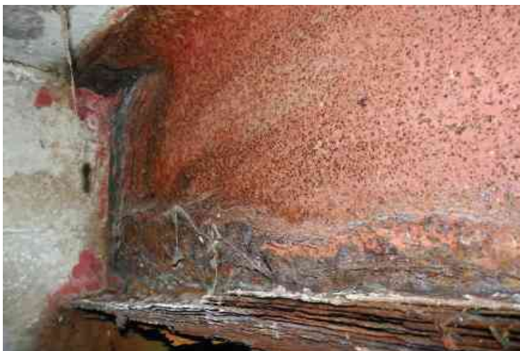
Stav ocelového nosníku
