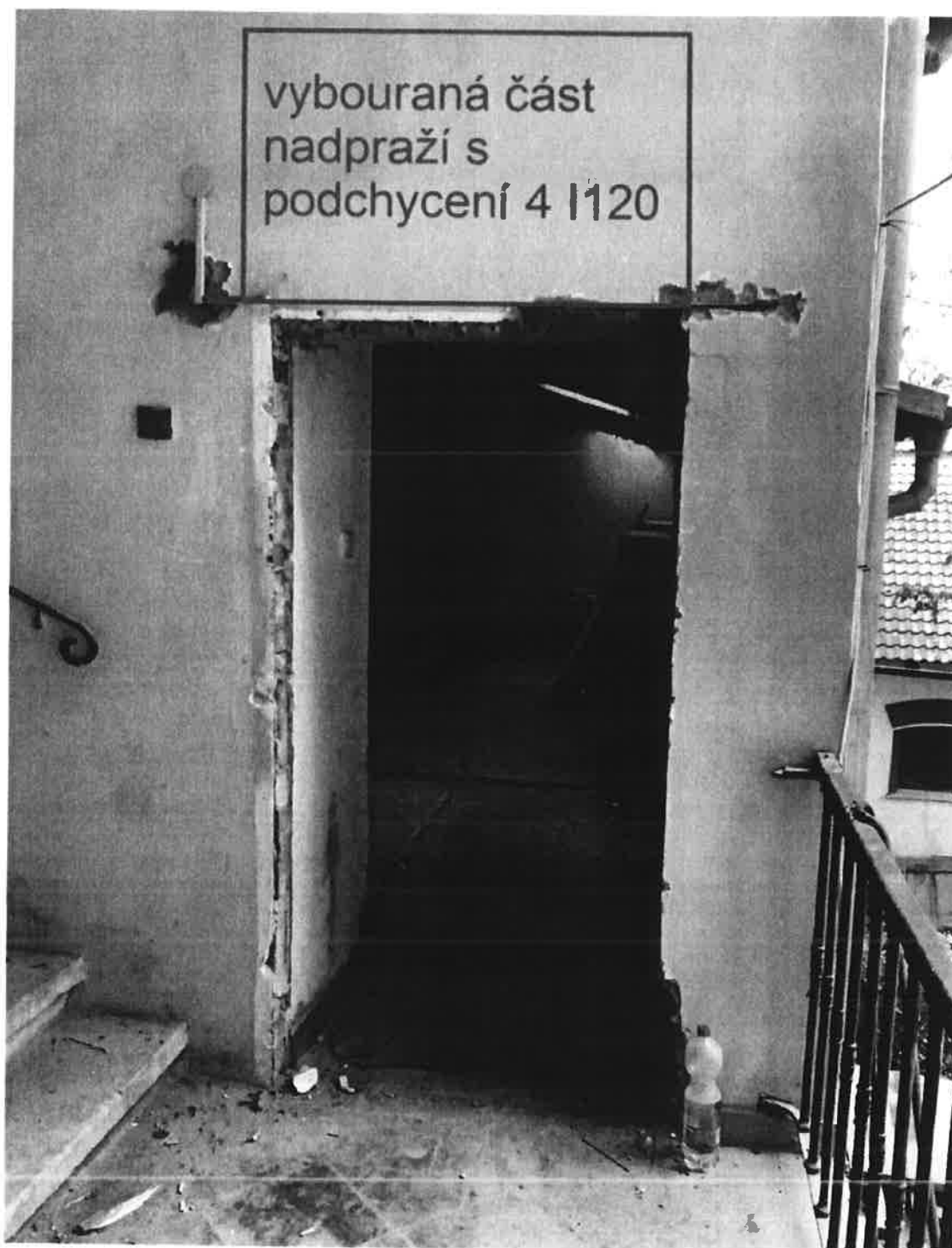
Příloha č.2 - zobrazení vybourané části nadpraží dveří do m.č.24.1
