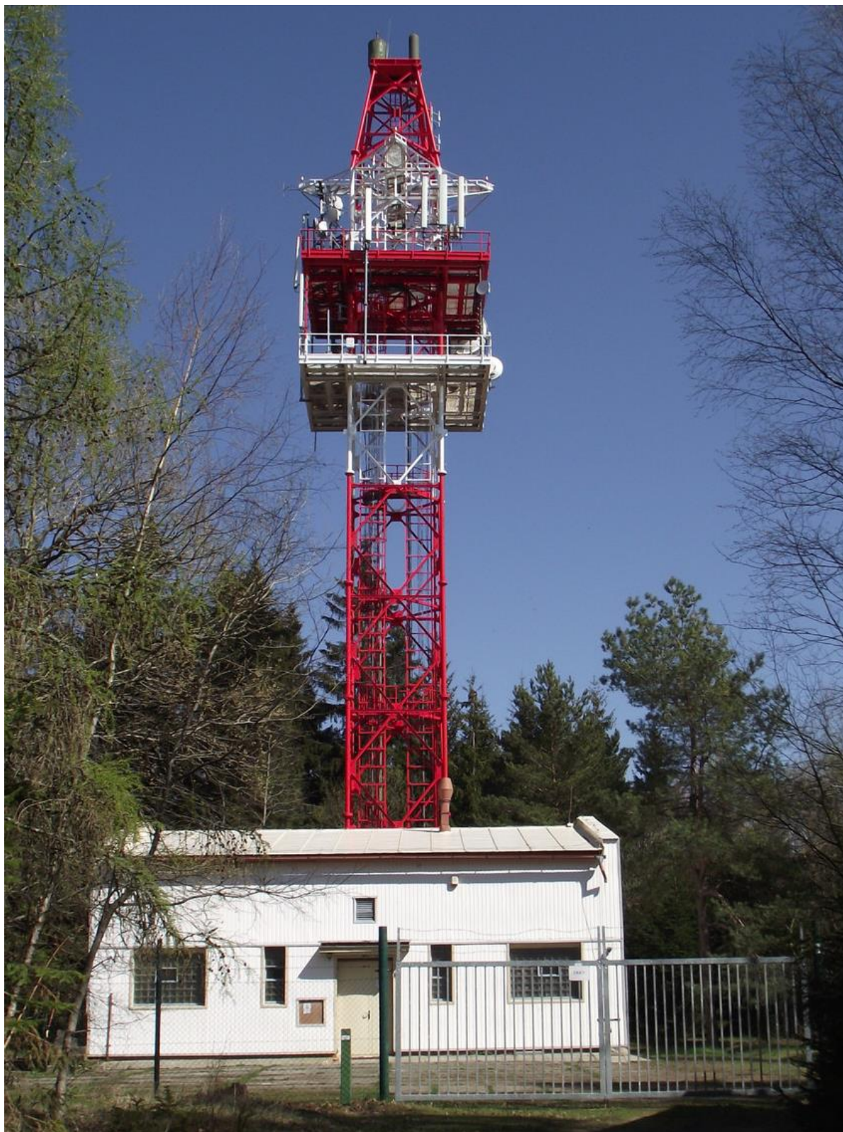
Obr. 1 Pohled na stanoviště Studánka Rozsocha
