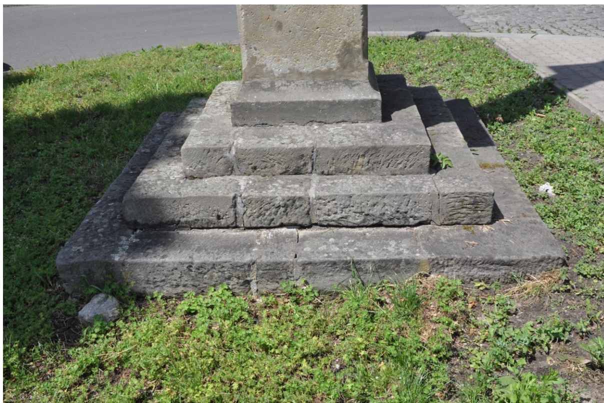
Obrázek 12 - Detail schodových stupňů, pohled zezadu, znečištění, zavlhčení spodní části objektu a s tím spojené masivnější biologické napadení a růst vyšších rostlin, nevhodné tmely, dožilé spáry
