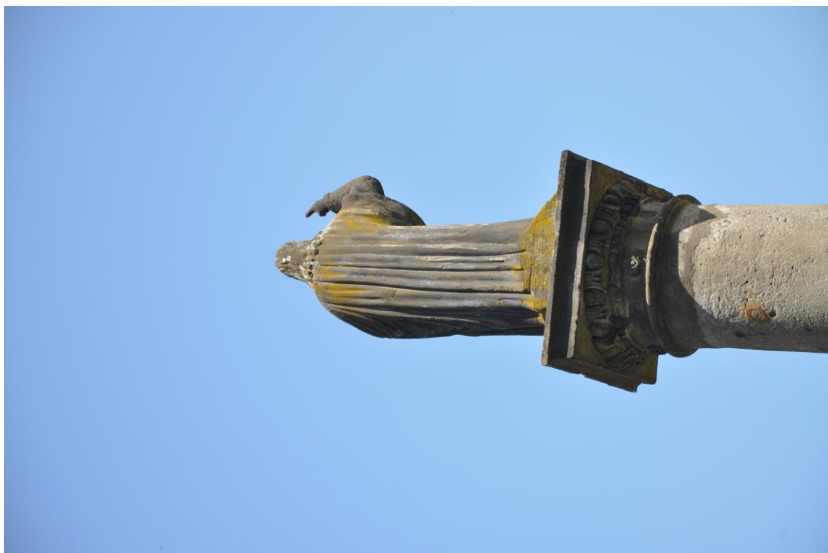
Obrázek 7 - Socha Krista, pohled zezadu, biologické napadení objektu, černé krusty
