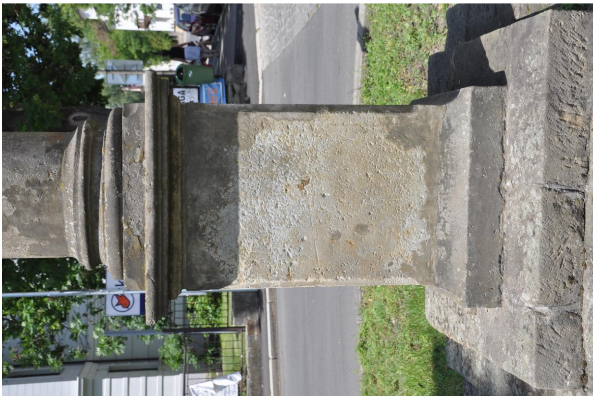
Obrázek 10 - Detail podstavce a schodových stupňů, pohled zprava, znečištění, biologické napadení, mechanické poškození, nevhodné tmely, spáry
