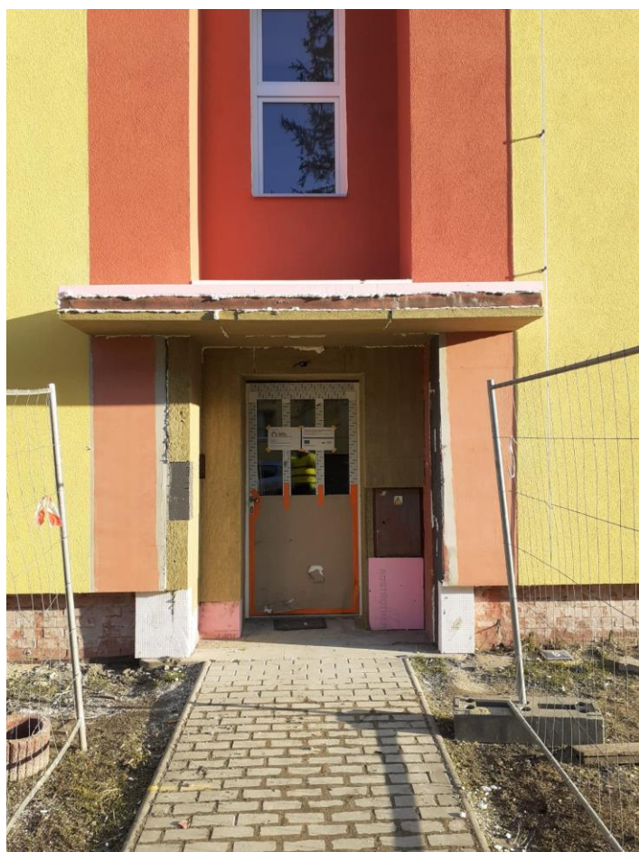
Vylepení XPS na horní část vstupní stříšky přední strany domu
