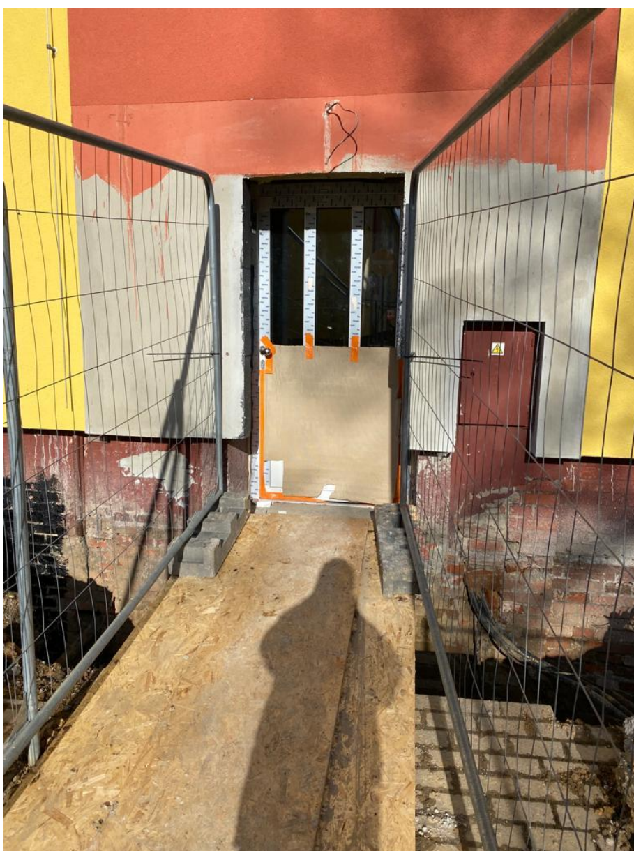
Montáž a demontáž provizorní lávky předního vstupu v době provádění výkopů
