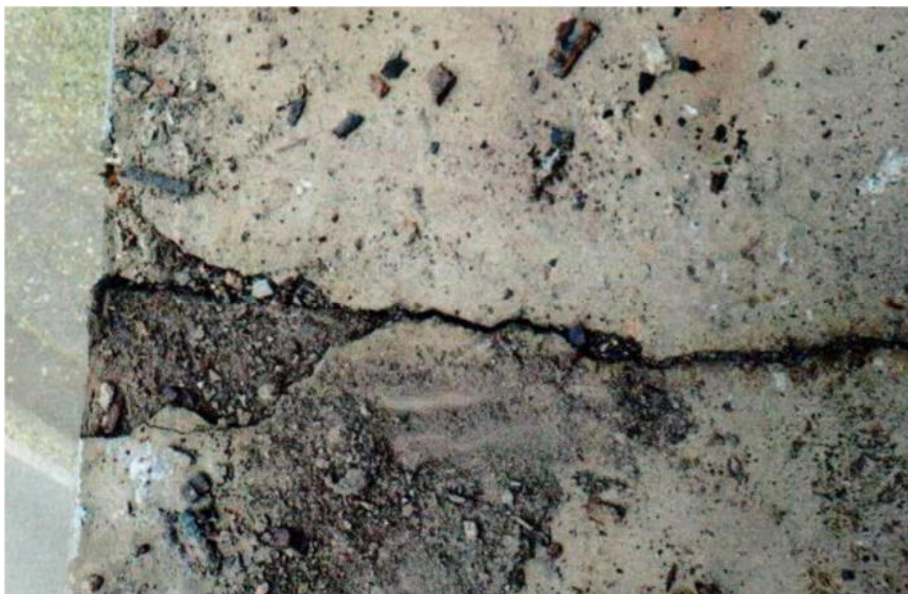
Trhlina v úložném prahu opěry 1 vpravo.
