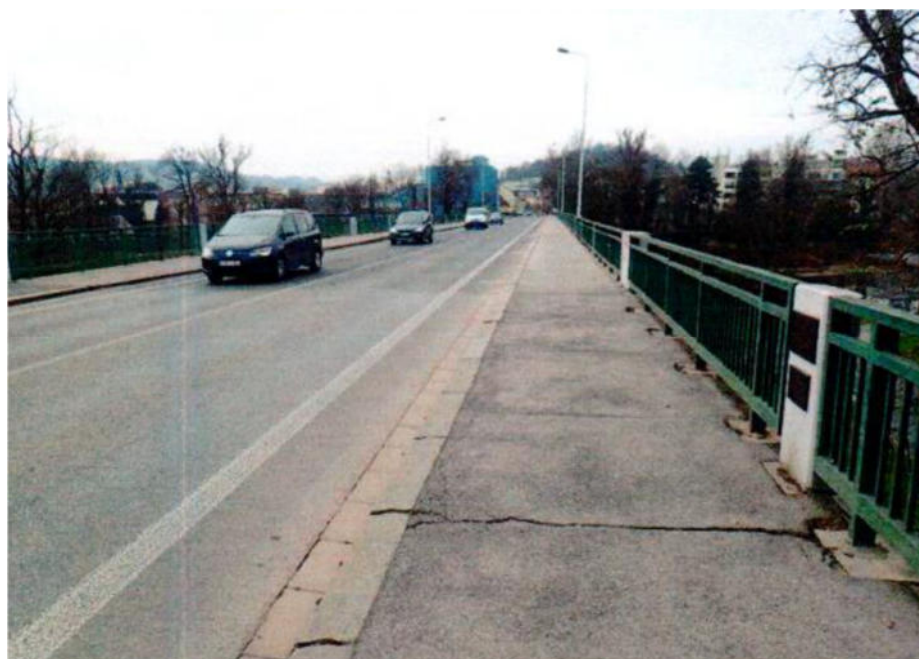
Pohled na most ve směru staničení.
