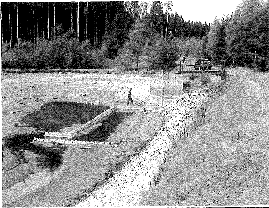
Obr. 7 Černý rybník. Celkový pohled na narušenou část hrázového tělesa, která bude zajištěna návodním těsněním z folie HDPE tl. 0,7 mm a odláždění hráze. Pohled na vtokovou jímku požeráku, která bude vyklizena od sedimentů.
