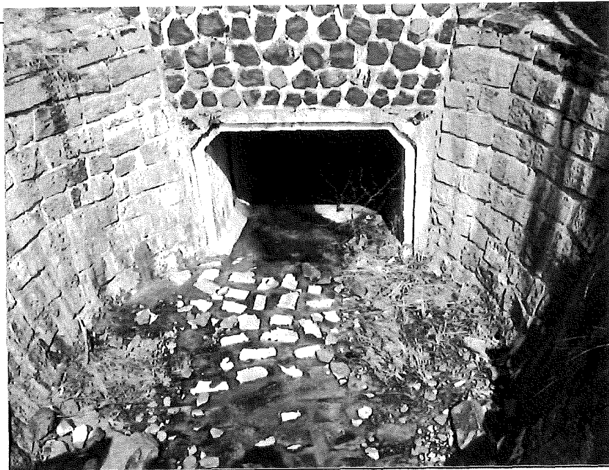
Obr. 7 Černý rybník. Celkový pohled na narušenou část hrázového tělesa, která bude zajištěna návodním těsněním z folie HDPE tl. 0,7 mm a odláždění hráze. Pohled na vtokovou jímku požeráku, která bude vyklizena od sedimentů.
