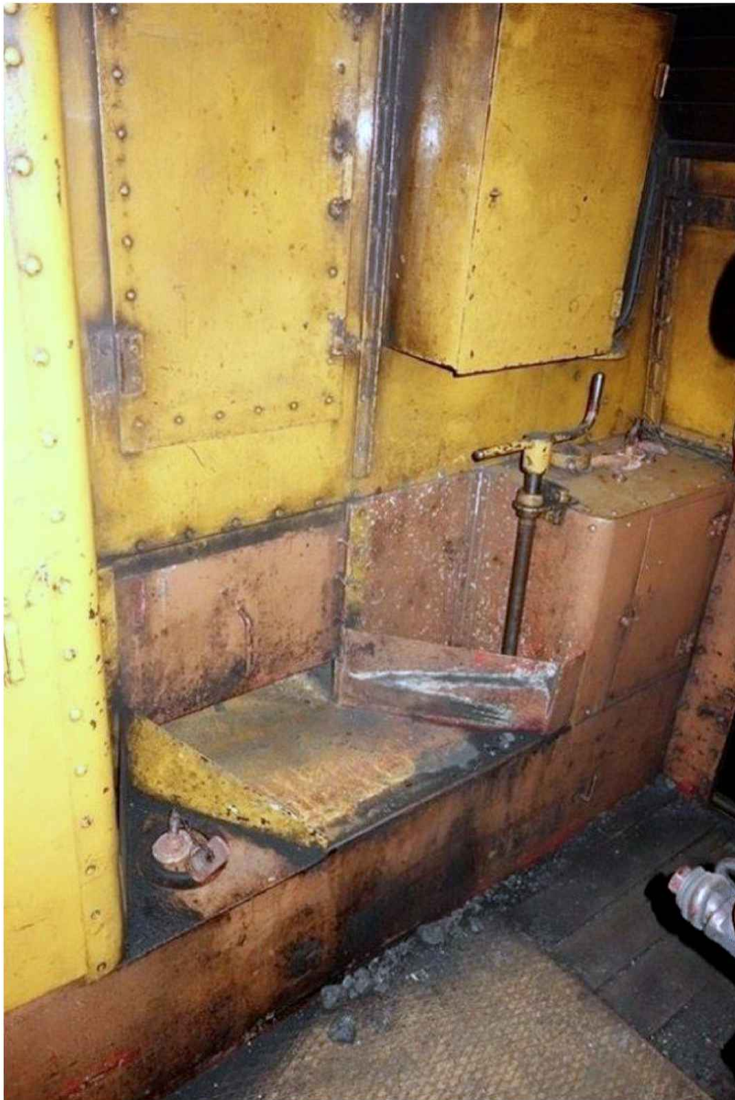
Obr. 37 Zadní stěna budky s lopatářem. Na fotografii kontrastuje dvoubarevné schema nátěru stanoviště, které odpovídá originálnímu z roku 1940.
