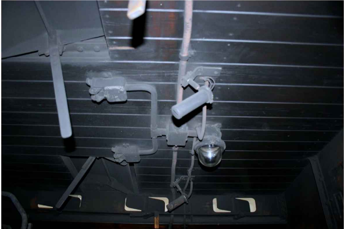
Obr. 40 Palubkové obložení stropu stanoviště se vyčistí a zachová.
