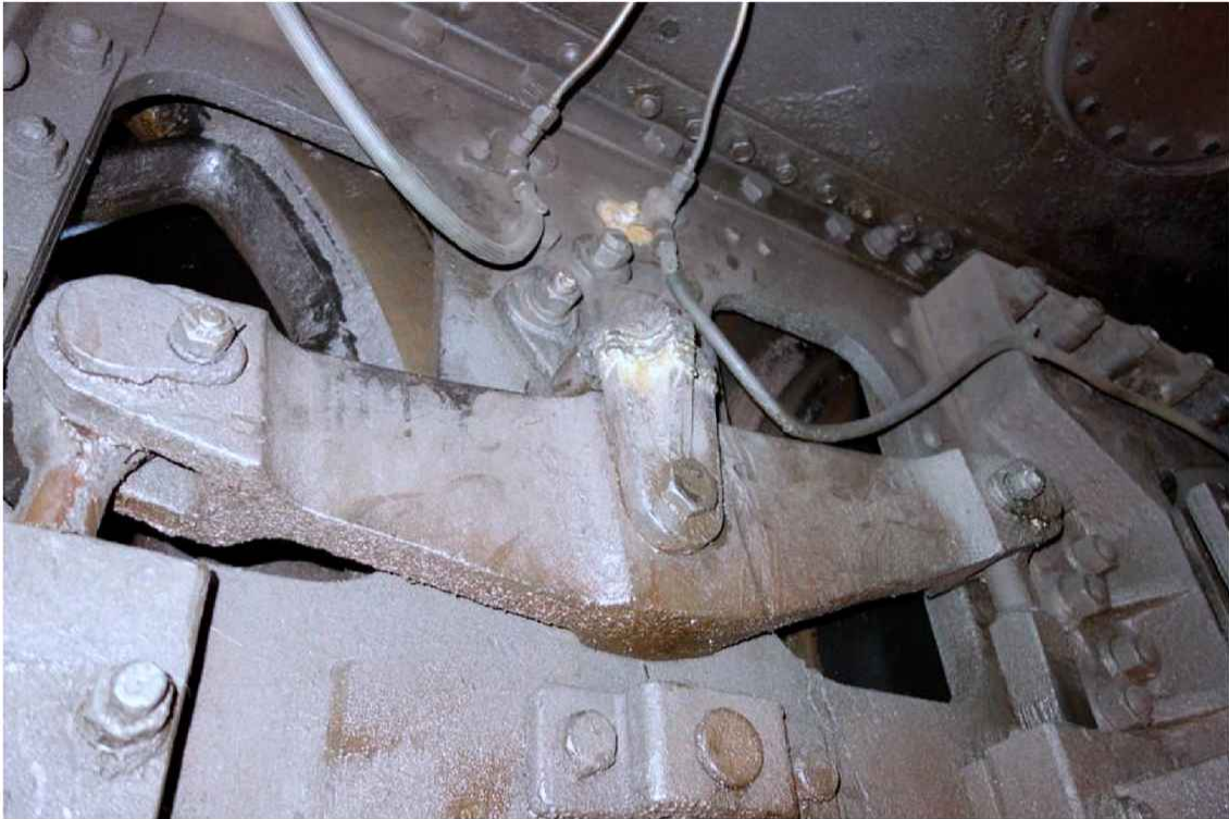
Obr. 31 Prasklina kozlíku vahadla mezi nápravami H a S 2 opravená svarem. Závěsky všech pružnic a vahadel vykazují nadměrnou vůli ve svislých vedeních i v čepích.
