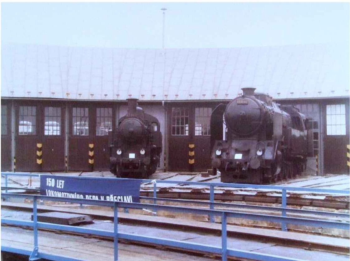
Obr. 6 Depo Břeclav, září 1989 [10].
