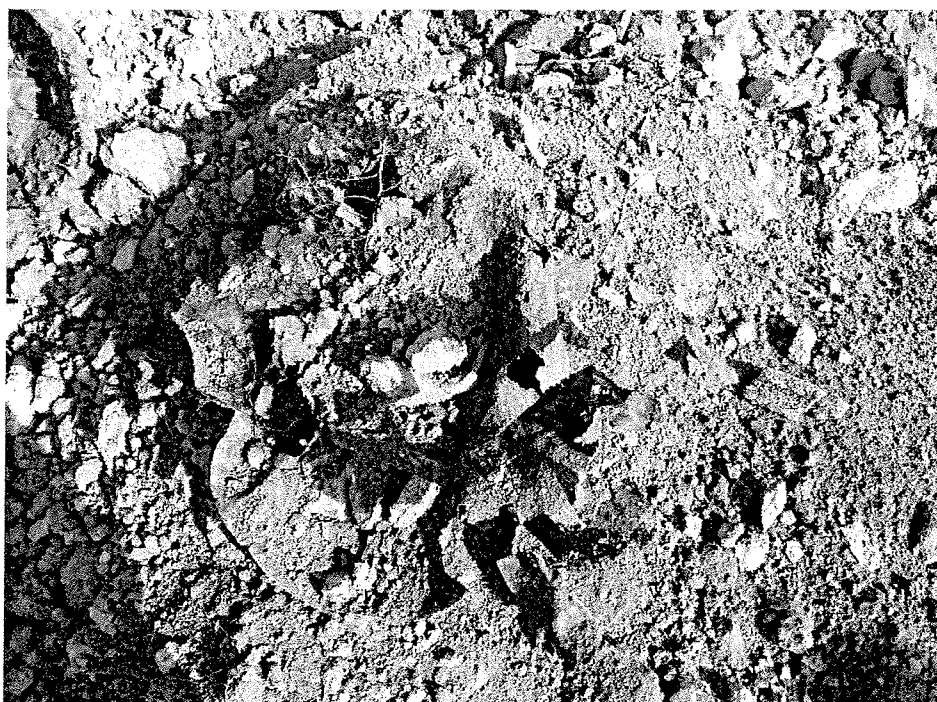
Obr.5 Signál A4, B1 se nacházel ve svahu mimo obvod haly v okolí bodu B1. Provedenou kopanou sondou bylo zjištěno, že se jedná o odpadní jámu obsahující tepelnou izolaci horkovodu (krycí plechy a skelnou vatu). Na obrázku je jeden z plechů
