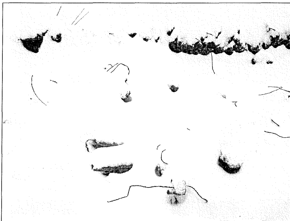
Obr.3 Prohlubeň zasypaná rozlámaným železobetonem. Ze sněhu trčí dráty
