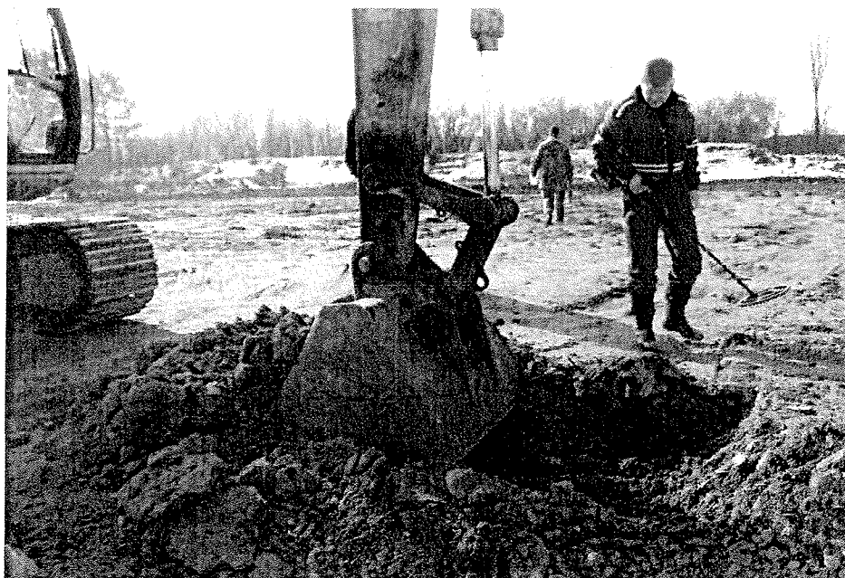
Obr.4 Pozice všech naměřených bodů byly přeneseny do terénu a následně byly ověřeny kopanou sondou (bagrem) pod trvalým dozorem pyrotechnika. Pyrotechnik s detektorem při prověrce signálu.
