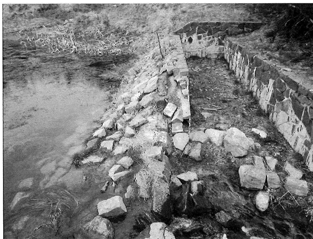
Pohled na konstrukci zdi BP
