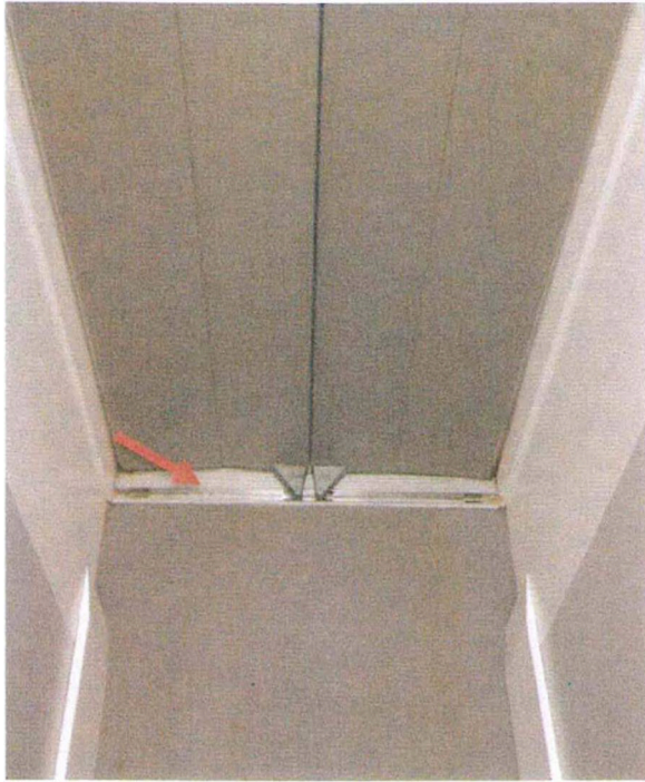
- čištění vodící drážky výtahové kabiny - 2 x týdně
