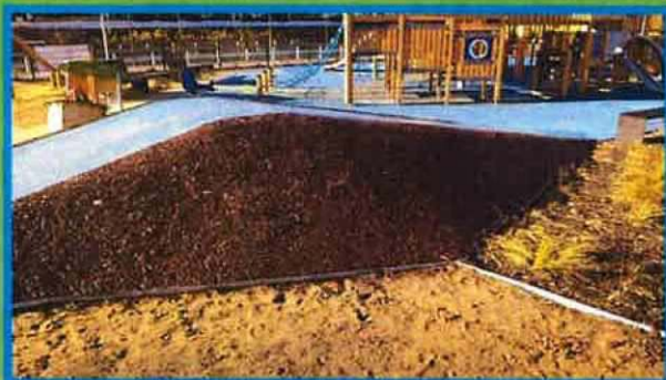
Ukázka realizace na nerovném terénu a svazích...
