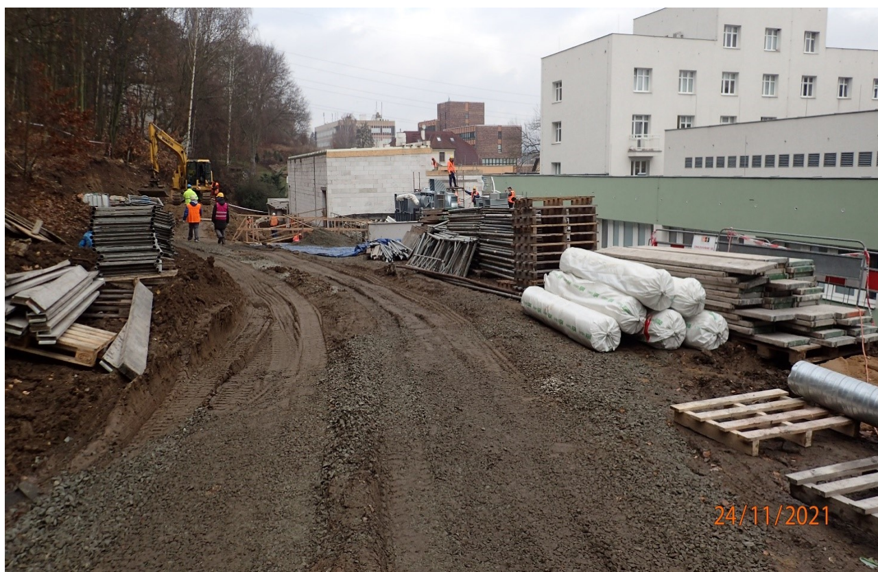
Fotografie z probíhající stavby:
