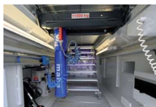
22. předváděcí plně funkční montážní jáma 1:1
