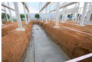
7. připravené betonové základové desky
