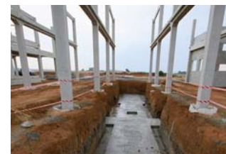
6. připravené betonové základové desky
