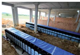
10. montážní jámy po usazení na základovou desku
