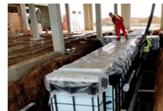
12. šalování a betonáž montážní jámy
