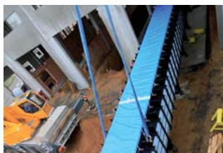
9. manipulace montážní jámy na základovou desku do již stávajícího objektu
