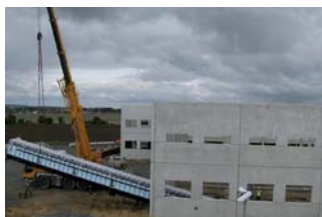
8. manipulace montážní jámy na základovou desku do již stávajícího objektu
