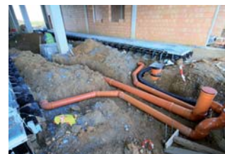
11. napojení periférií montážní jámy
