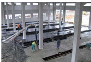
15. betonáž montážních jam
