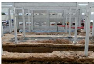
13. betonáž montážní jámy
