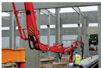
14. betonáž montážní jámy
