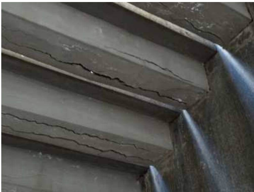
Obr.1 Dvouramenné schodiště – pohled zespodu na konzolové stupně
