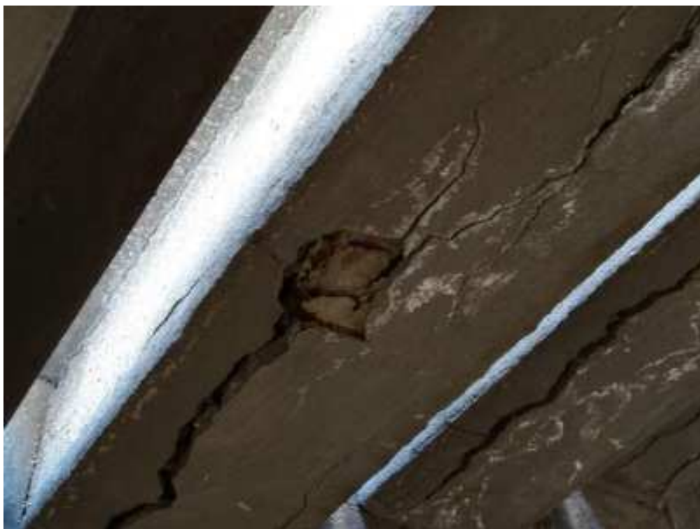
Obr.3 Detail porušeného konzolového stupně na dvouramenném schodišti
