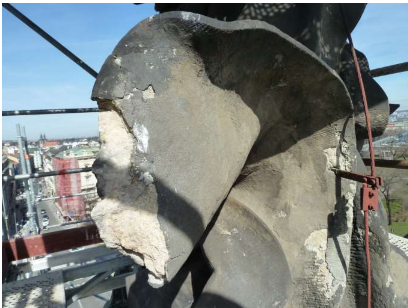
Socha múzy. Zadní drapérie. Odlomená část kamene ze značně rozpraskané drapérie.
