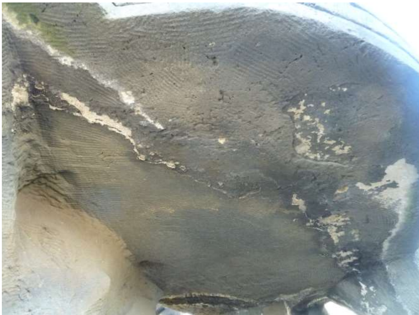
Sousoší Alegorie Dionýsa. Spodní část vozu. Silná vrstva černé krusty a cementový potěr, překrývající degradovaný povrch kamene.
