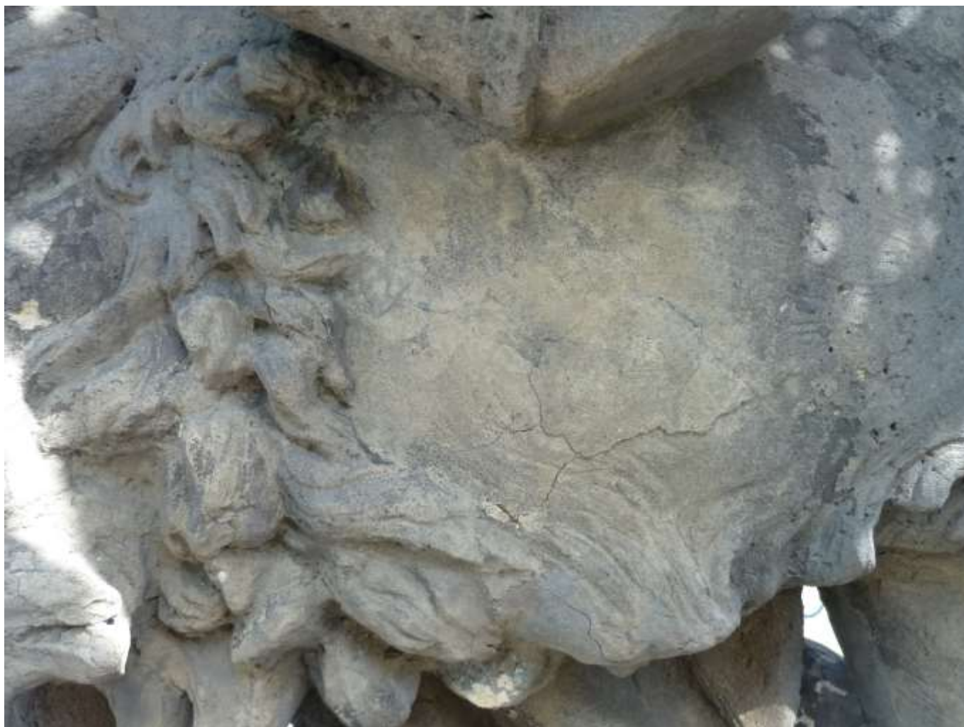
Sousoší Allegorie Thálie. Socha lva – levý bok. Rozpraskaná vrstva cementového tmelu.
