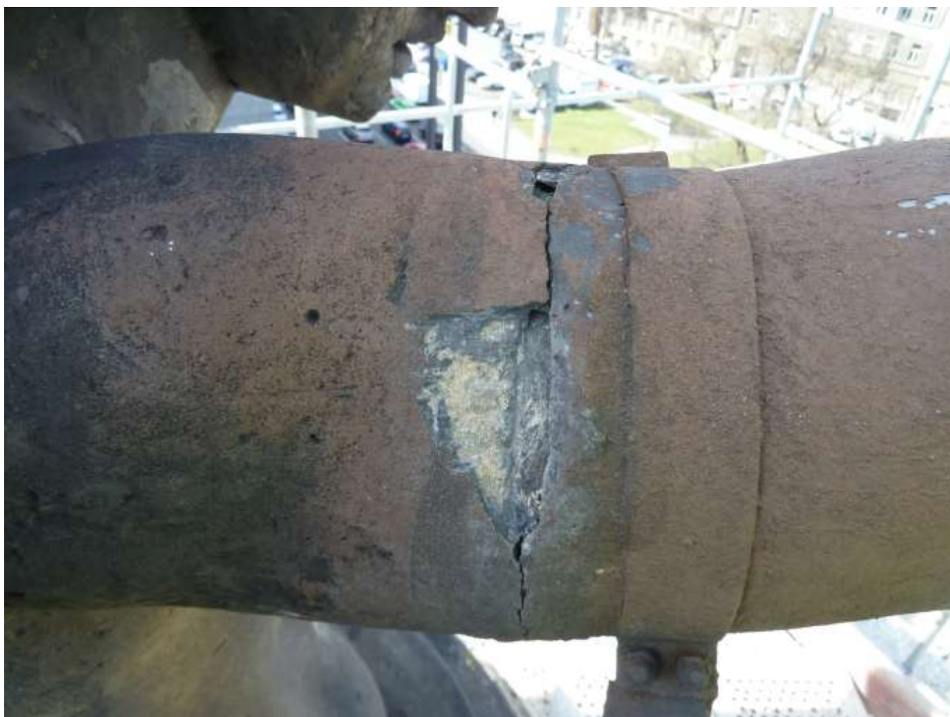
Sousoší Alegorie Thálie. Detail napojení pravé ruky ze zinkového plechu s nevhodnými cementovými nánosy z minulých zákroků
