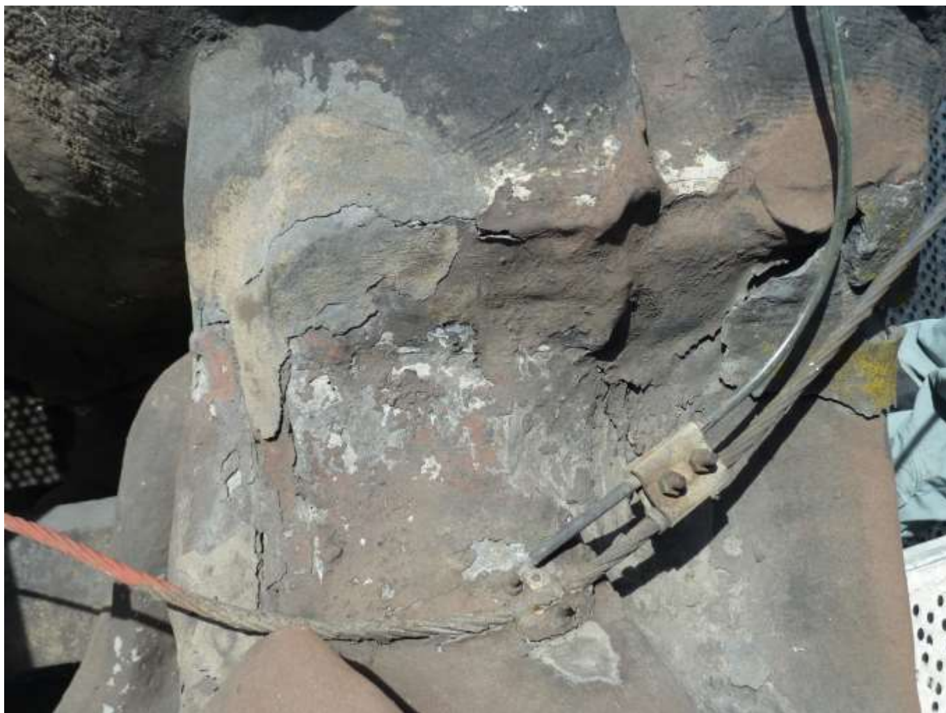
Sousoší Alegorie Thálie. Detail napojení drapérie ze zinkového plechu s nevhodnými cementovými nánosy z minulých zákroků
