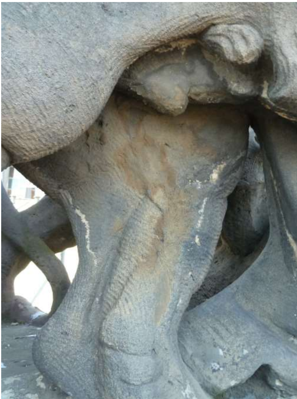
Sousoší Alegorie Dionýsa. Detail zadních končetin sochy Iva. Lokální zasolení kamene.
