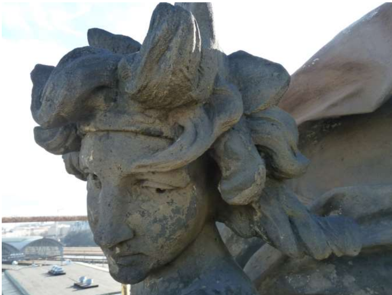
Sousoší Alegorie Dionýsa. Fragment barevného sjednocení světlým okrovým nátěrem v obličejové části.
