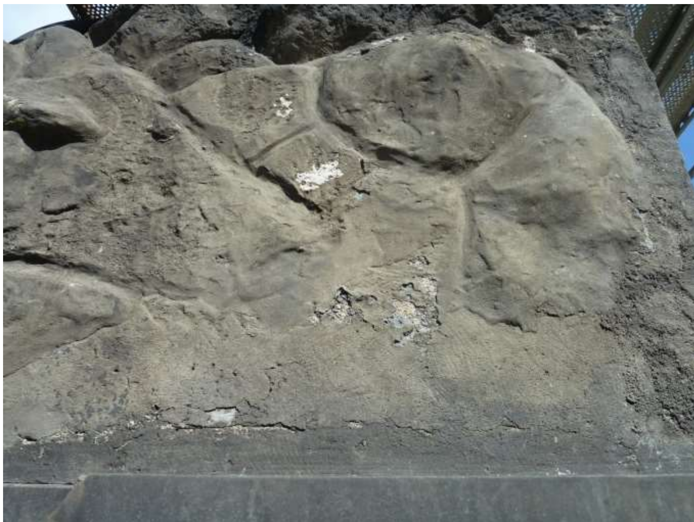
Sousoší Alegorie Thálie. Podstavec sousoší – pravý bok. Vyzdřená a přeštukovaná část podstavce.
