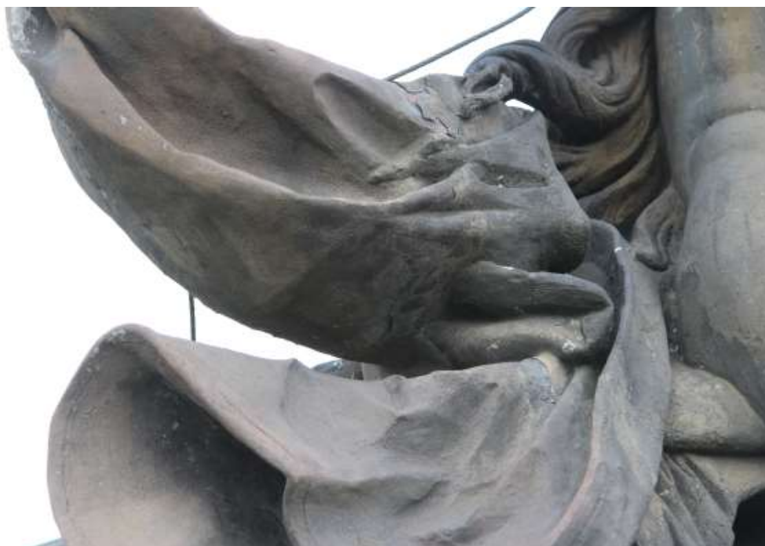
Postava Thálie – detaily vyžilého spárování
