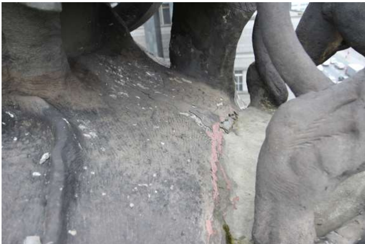
Postava Thálie – detail vyžilého spárování
