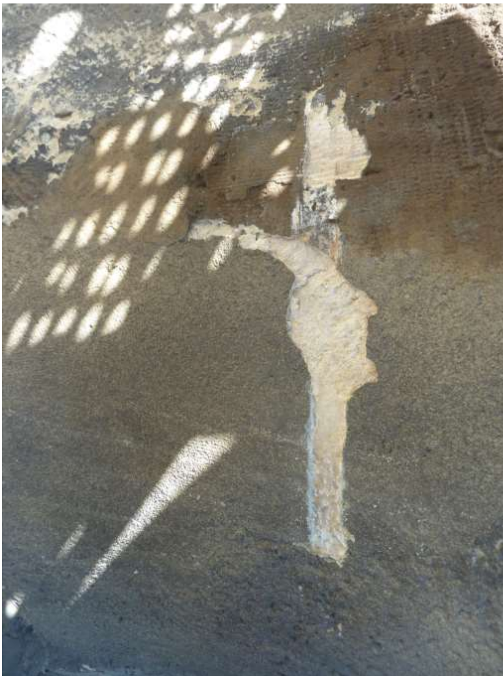
Sousoší Alegorie Dionýsa. Zadní pohled vozu. Cementový potěr, překrývající degradovaný povrch kamene.
