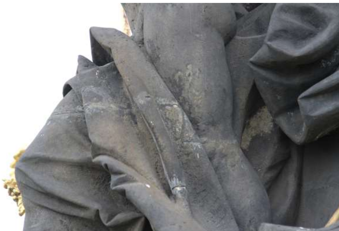
Postava Dionýsa – detaily povrchu zasaženého krustou
