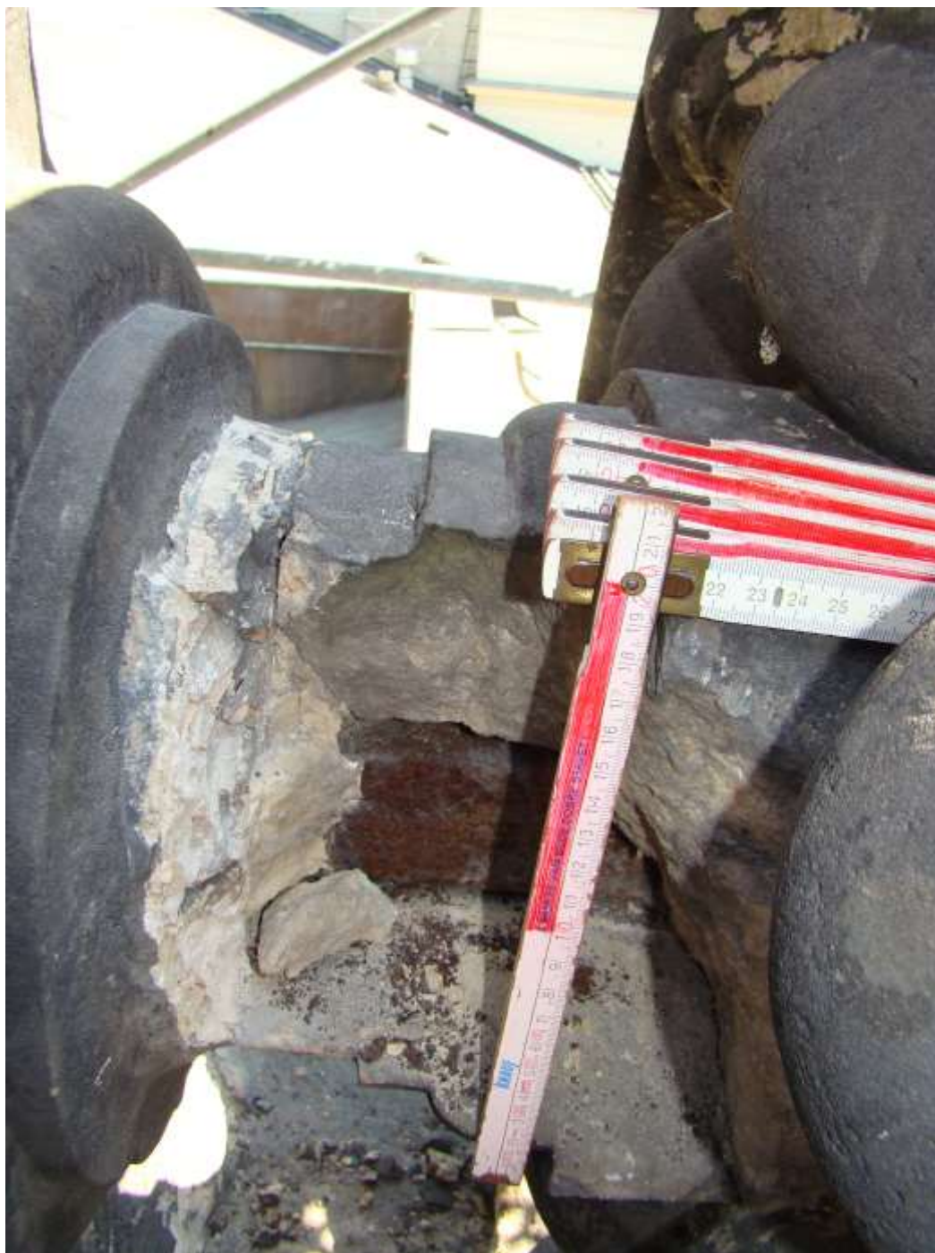
Roztržený náboj levého kola s korodujícím železným čepem.
