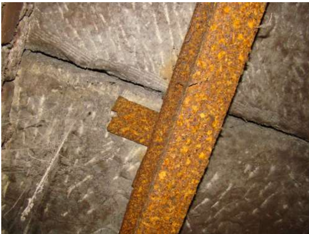
Doklínování ocelovými vložkami vodorovné styčné spáry mezi kamenem a ocelovým nosníkem zděného základového objektu.
