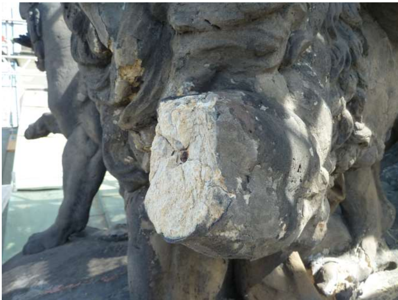
Sousoší Alegorie Thálie. Socha lva. Odlomená levá tlapa se zbytkem zkorodovaného železného čepu.
