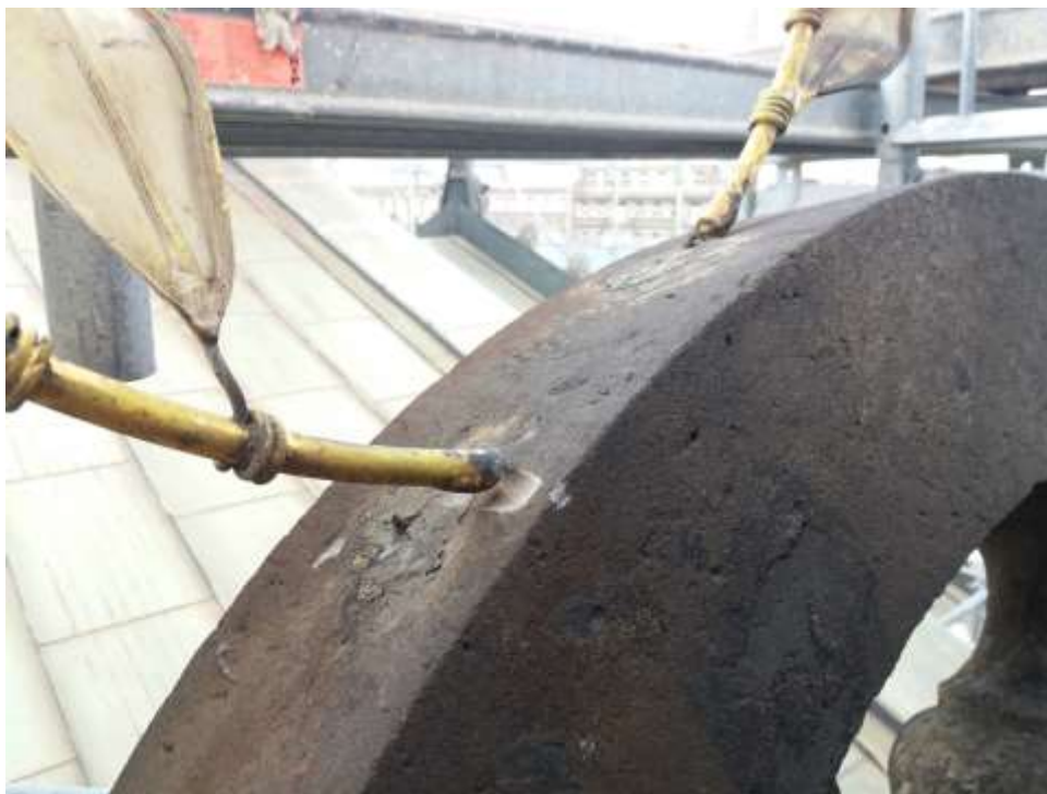
Sousoší Alegorie Dionýsa. Přetržené kotvení ozdoby. Destruktivní kontakt s kamenem.
