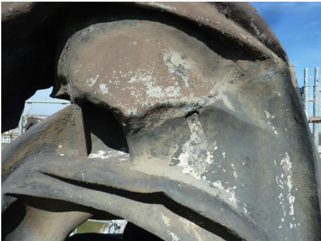
Sousoší Alegorie Dionýsa. Zadní drapérie. Napojení části drapérie ze zinkového plechu.
