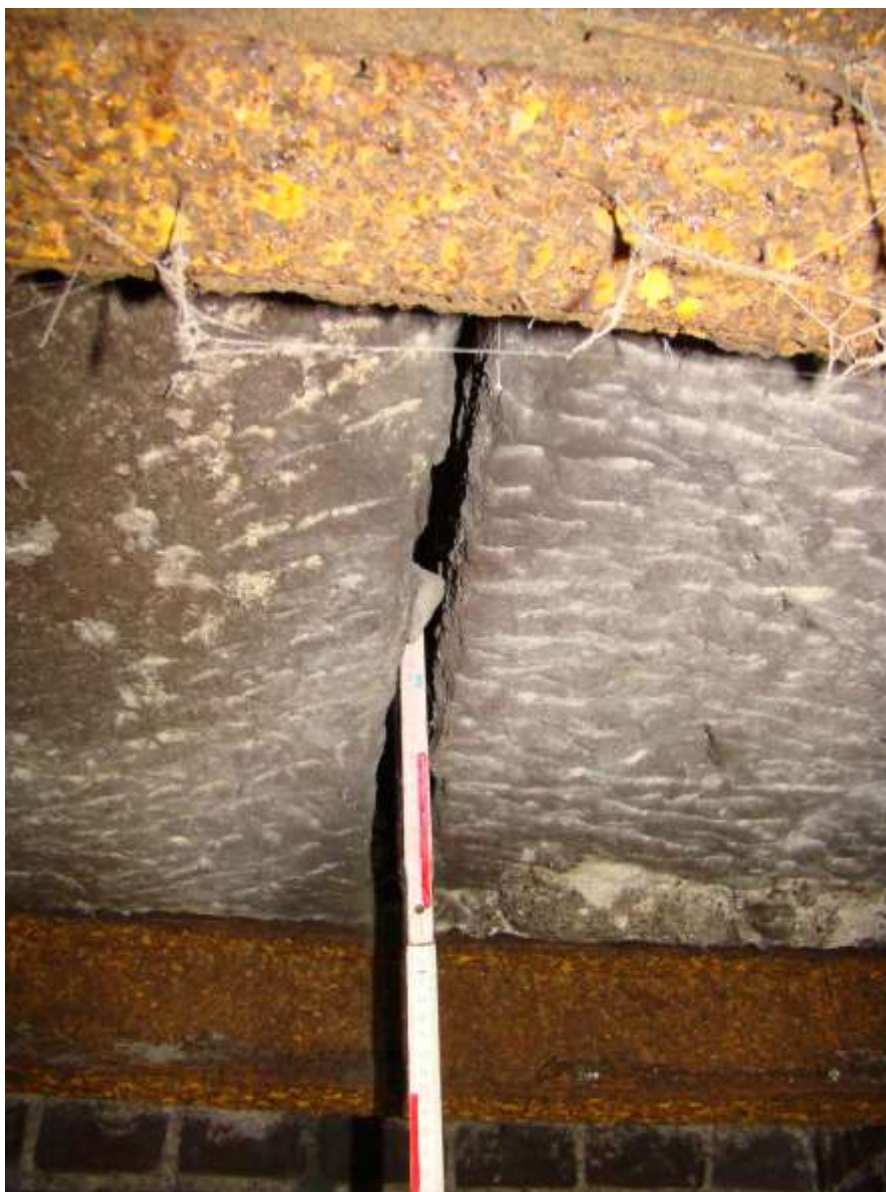
Svislá spára mezi kameny základu sousoší (Dionýsa)
