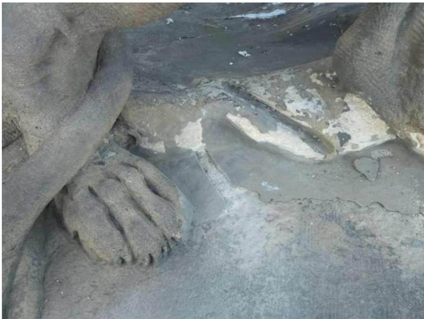
Sousoší Alegorie Dionýsa. Socha Iva. Detail degradovaného kamene pod vrstvou cementového tmelu.
