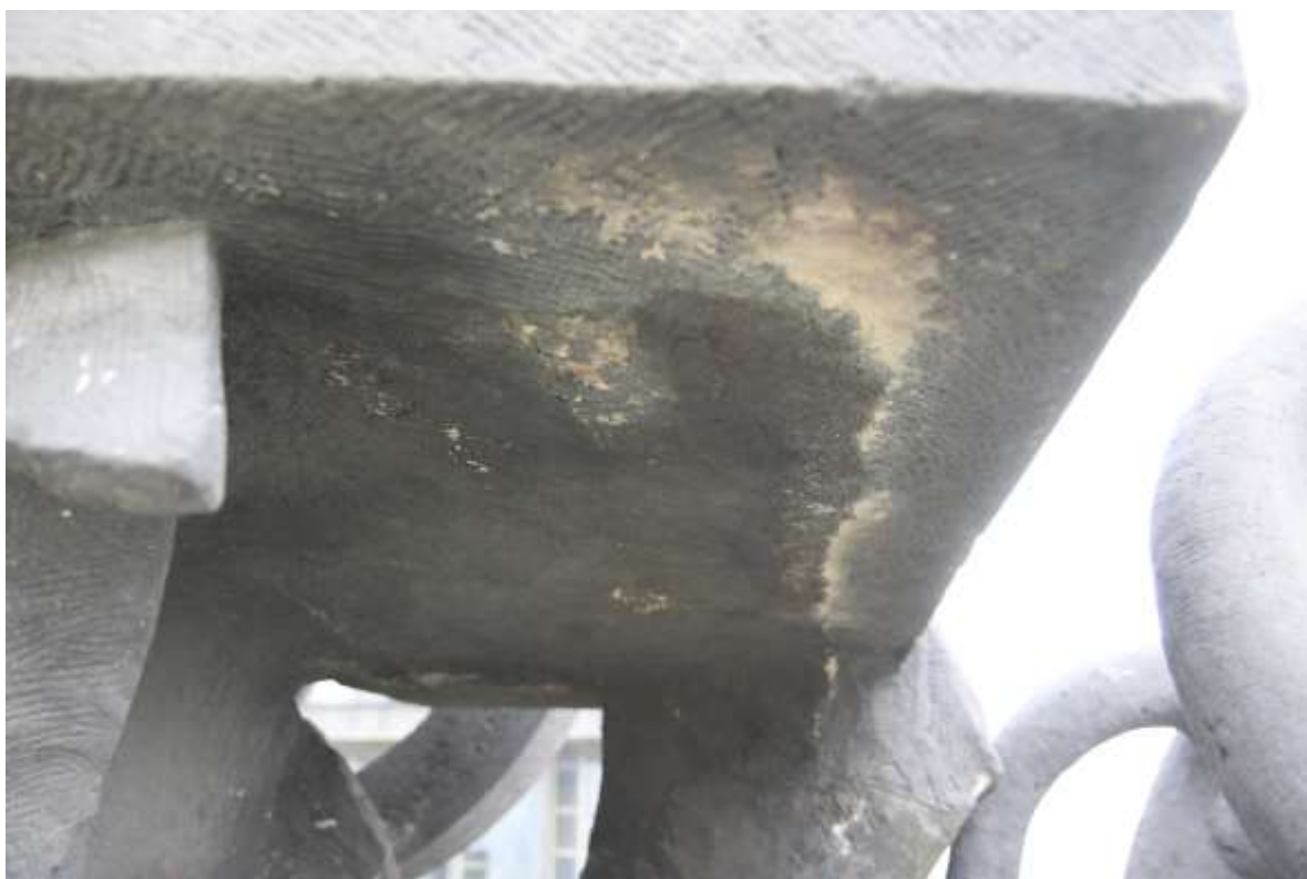
Postava Thálie – detail degradace kamene a tmavé krusty ve stínových místech
