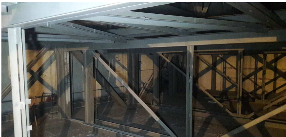
Provazistišě- Vazníky, krajní rámové okno pro průchod
