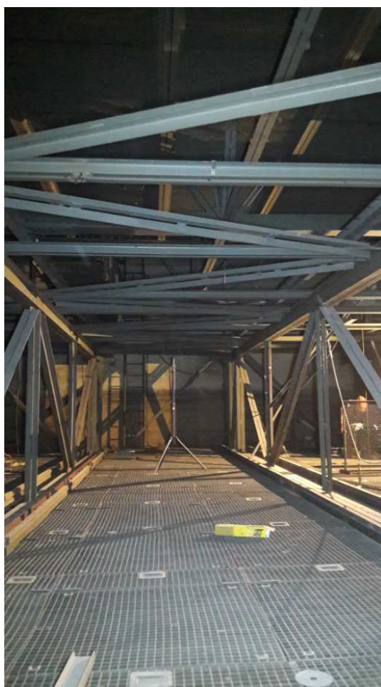
Provaziště- Vazníky pásy 2U180/10 (horní vodorovné ztužení)
