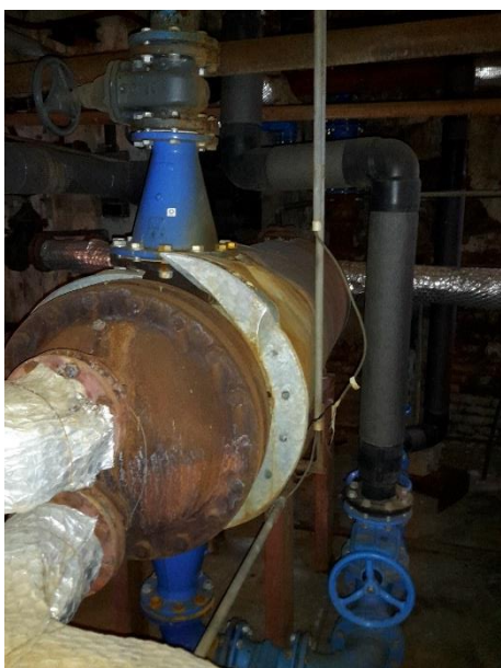
Obrázek 7: Dochlazení kondenzátů - předeřev TV
