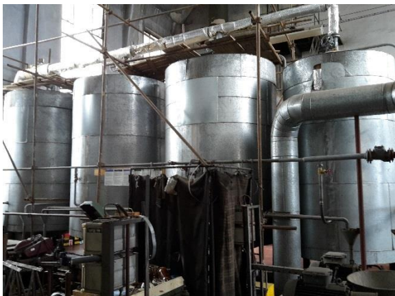
Obrázek 6: Nepřímotopné ohřivače TV cirkulační čerpadla TV
