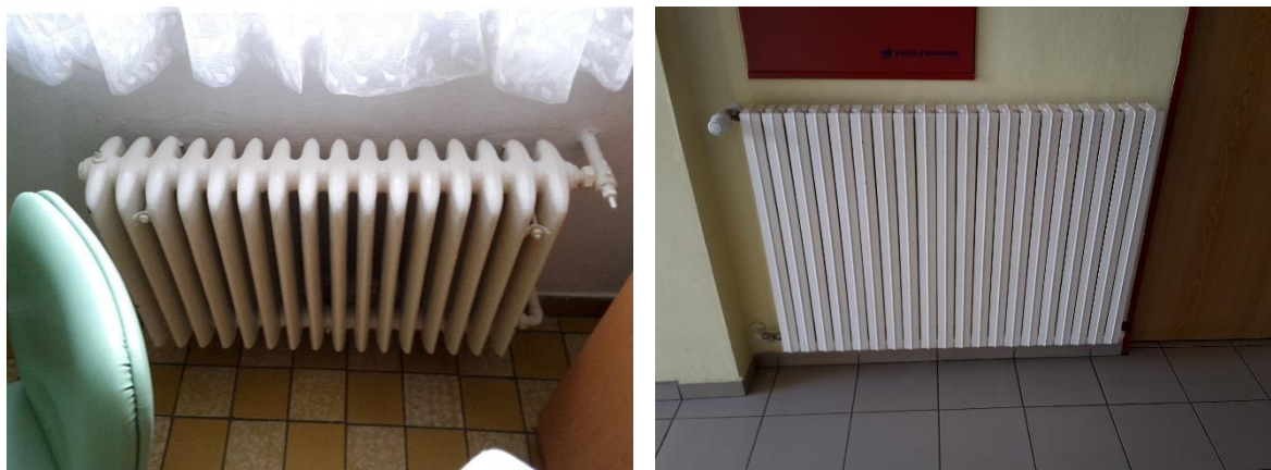
Obrázek 12: Otopná tělesa s TRV a bez TRV
