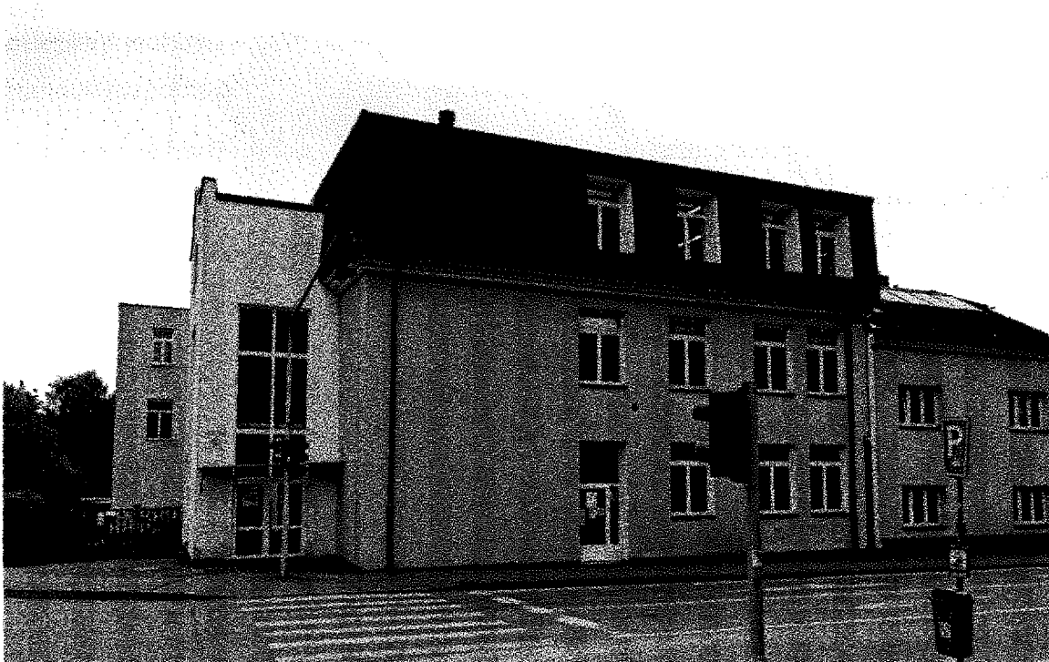
Obrázek 2: Pohled na budovu označenou „A“
