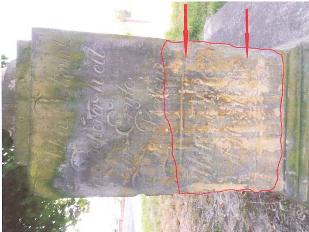
Spodní část kamene je poškozena vodním sklem, kámen je zasolený a drolivý.
