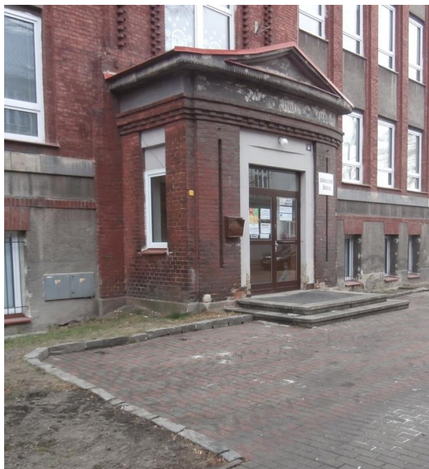
Foto č. 3 – hlavní vstup: Zrušení schodiškových stupňů
