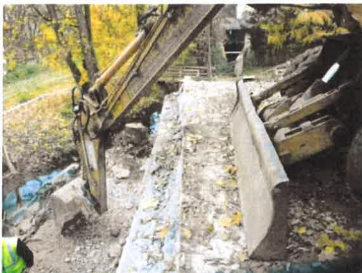
Celkový pohled na obnažený líc úložného prahu opěry 1.
