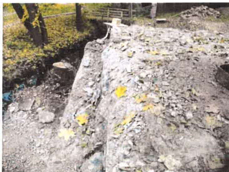
DTTO - v pravé části opěry.
