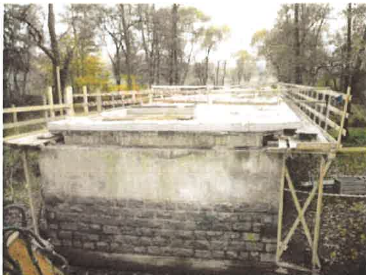
pohled na čelo NK nad pilířem 2.
