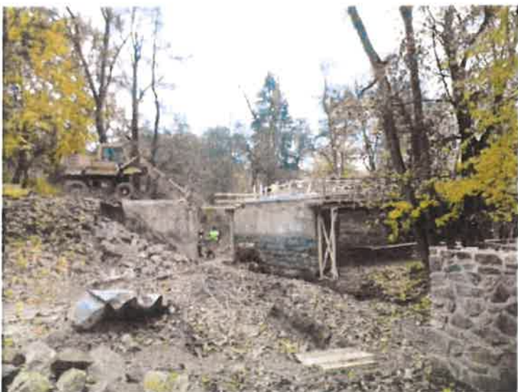
celkový pohled na staveniště v oblasti 1 pole
