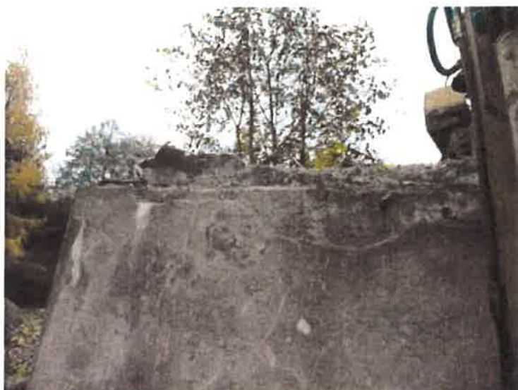
pohled na líc dřívku opěry 1
