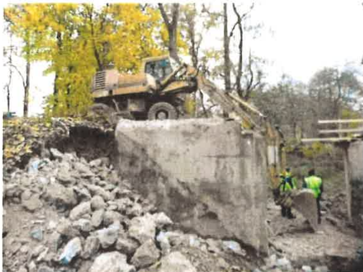
pohled na líc pravého křídla opěry 1
