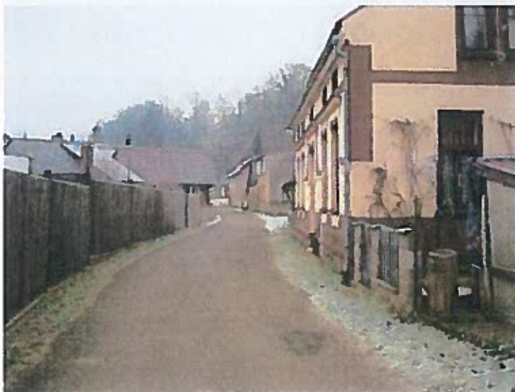
Pohled do Jílovské ulice od výtoku, část 3
