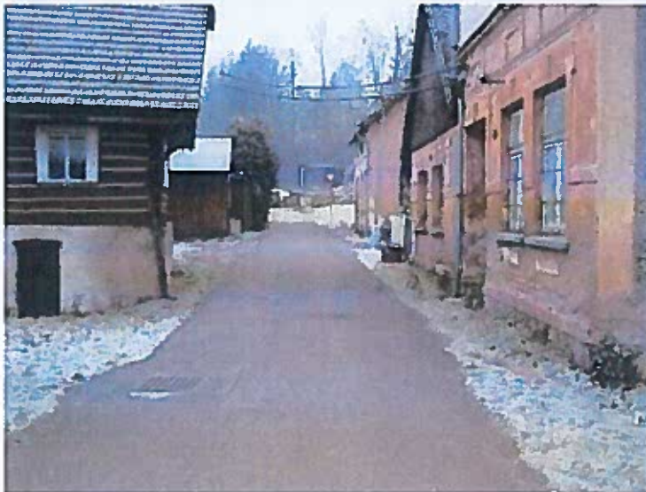
Pohled do Jílovské ulice od výtoku, část 3
