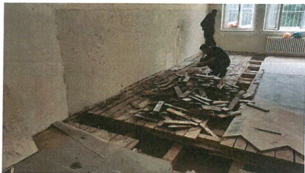
Demontáž stávajících parketových vlysů
