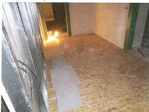
Montáž nových OSB desek
