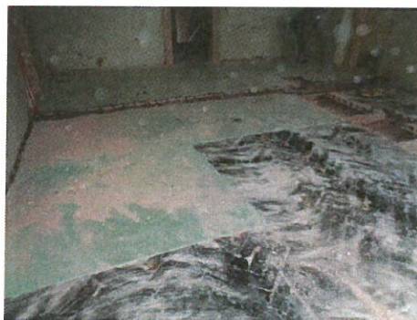
Demontáž stávajících parketových vlysů
