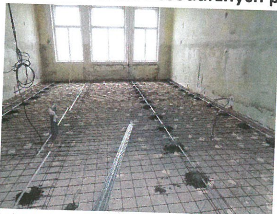
Místnost č. 1.09 – příprava před betonáží
