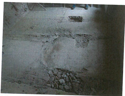
Místnost č. 2.04 – bourací práce
