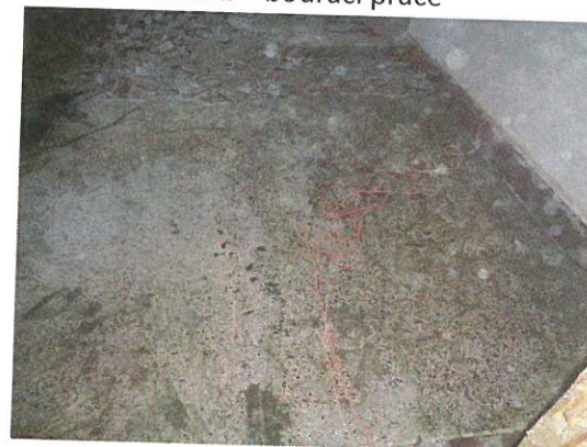
Místnost č. 2.02 – bourací práce
