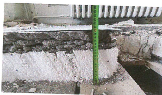
Místnost č. 2.11 – stávající skladba
