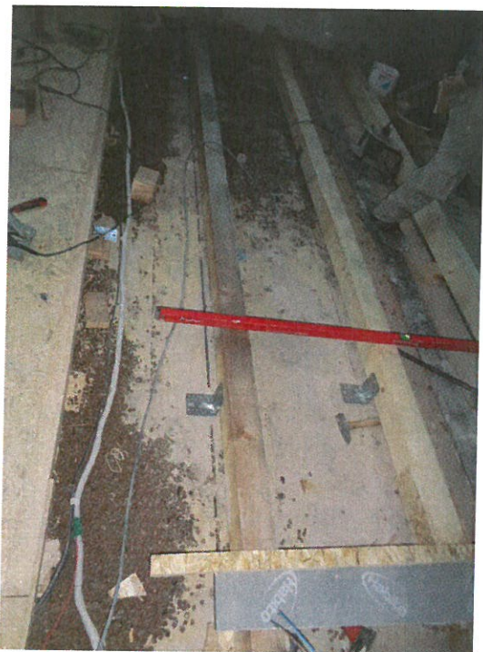
Místnost č. 2.11 – Provádění nové skladby
