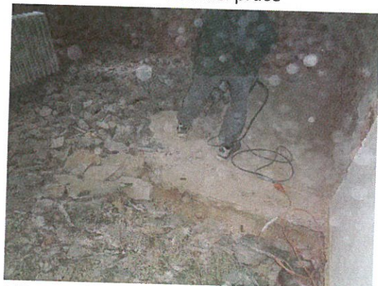
Místnost č. 2.01 – bourací práce
