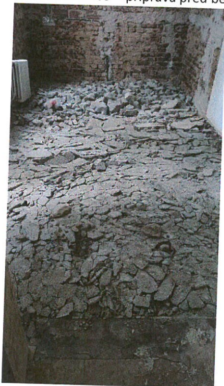
Místnost č. 2.01 – bourací práce
