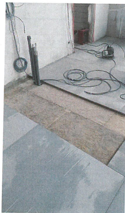
Místnost č. 2.11 – Provádění nové skladby
