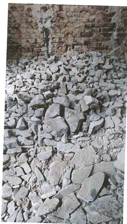
Místnost č. 2.01 – bourací práce
