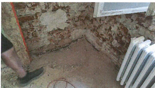
Osazování omítníků pro vyrovnání povrchu
