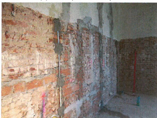
Osazování omítníků pro vyrovnání povrchu
