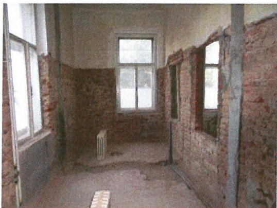
Začištěný povrch po otlučení obkladech
