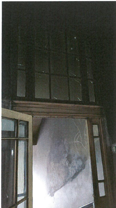
Chodba 2.06 – před rekonstrukcí
