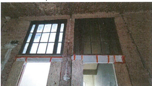
Chodba 2.06 – během rekonstrukce
