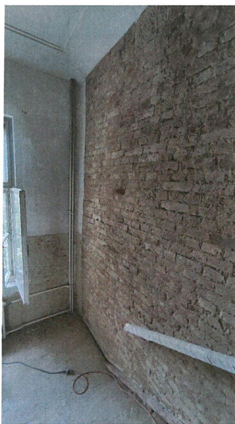
Schodiště 2.03 – během rekonstrukce
