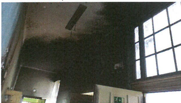
Chodba 2.06 – před rekonstrukcí
