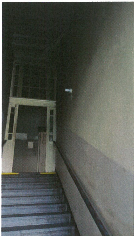
Schodiště 2.03 – před rekonstrukcí
