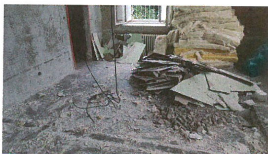
Místnost 2.11 – demontáž SDK příčky
