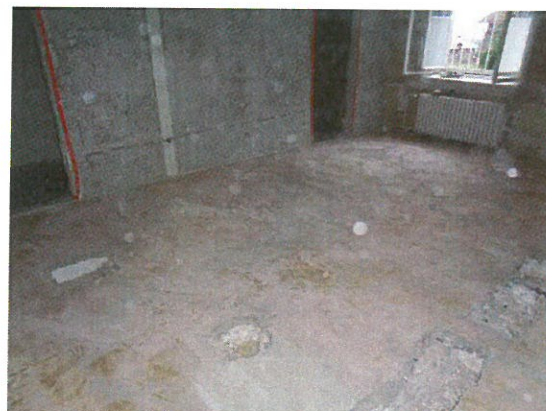
Místnost 2.11 – demontáž SDK příčky
