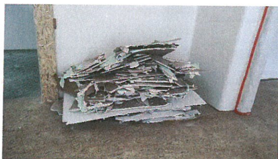
Demontáž SDK konstrukcí
