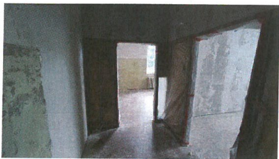
Místnost 2.07 – demontáž SDK záklopů
