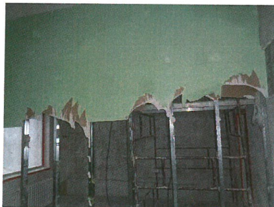
Místnost 2.11 – demontáž SDK příčky
