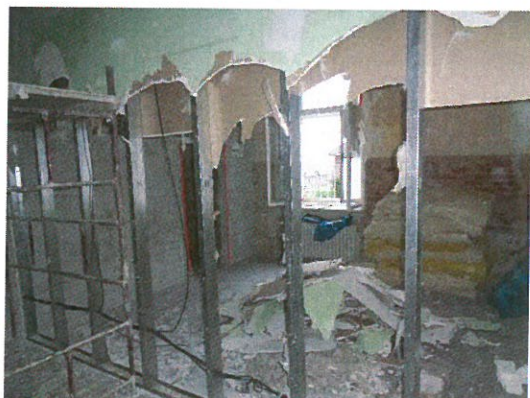
Místnost 2.11 – demontáž SDK příčky
