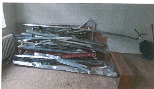
Demontáž SDK konstrukcí
