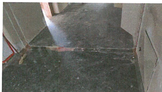
Místnost 1.08 - demontovaná příčka
