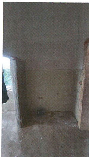
Místnost 2.07 – demontáž SDK záklopů
