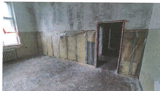
Místnost 2.07 – demontáž SDK záklopů
