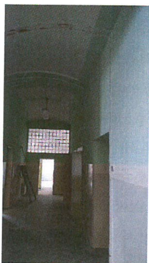
Místnost 1.08 - demontovaná příčka
