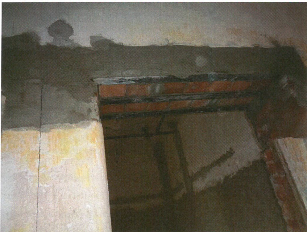
Montáž ocelových překladů s vyplněnými mezerami
