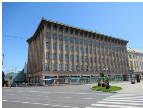
Stavba č. p. 159 a 160 - pohled Z
