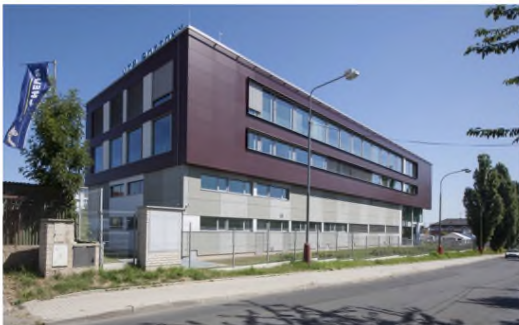
Obrázek 1 Budova s laboratořemi ve VTP Roztoky
