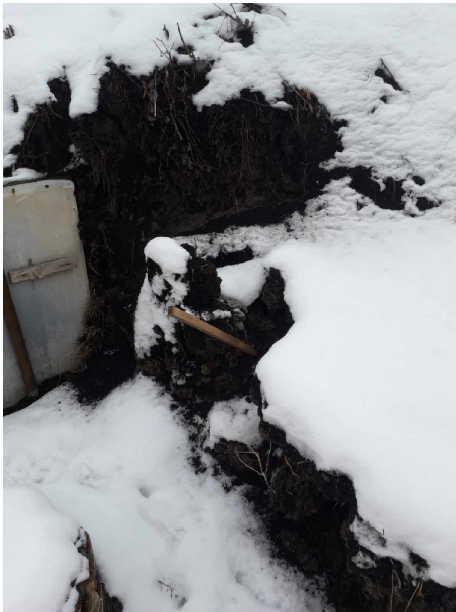
Obrázek 4 Detail na vyvrácenou kontrolní tyč pokračujícího sesuvu
