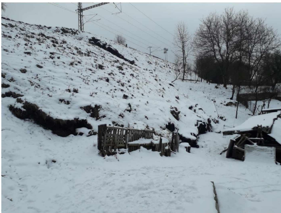
Obrázek 2 Pohled na sesuv od paty svahu (dřevník vpravo)
