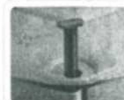
Pojistky zabraňují samovolnému otevření větrem
