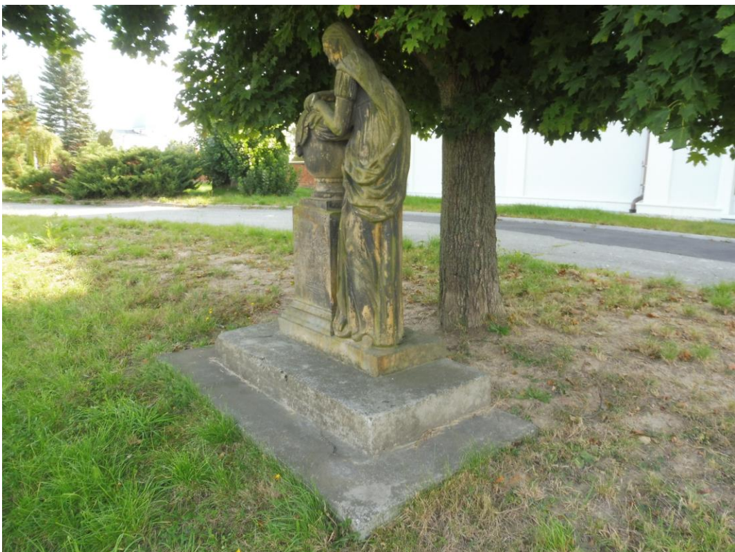
Památka je pokryta biologickým napadením, mechy a lišejníky. Na soše je velké množství tmavých depozitů a krust.
