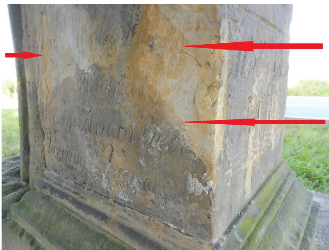
Poškozené chybějící písmo, kámen je zasolený, drolivý.
