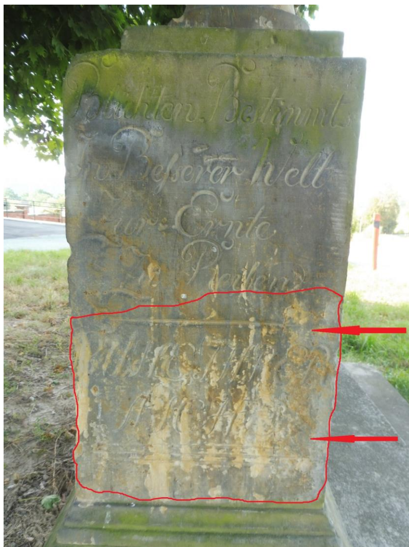
Spodní část kamene je poškozena vodním sklem, kámen je zasolený a drolivý.
