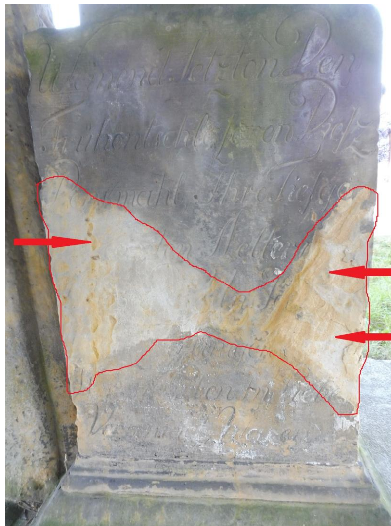
Spodní část kamene je poškozena vodním sklem, kámen je zasolený a drolivý.
