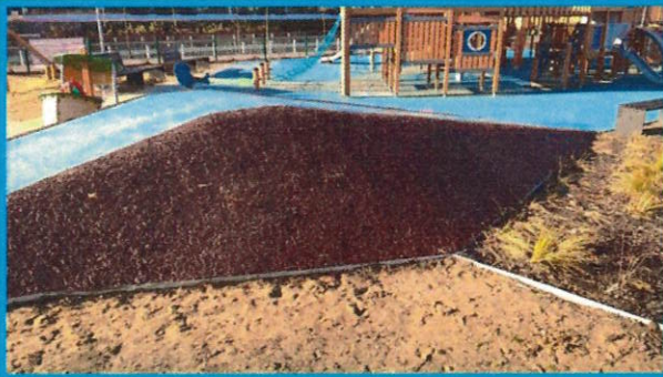
Ukázka realizace na nerovném terénu a svazích....
